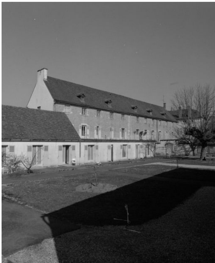
Elévation est de l'hôtel et du bâtiment le prolongeant, vue prise de la cour du Grenier à sel. 21, Beaune Marie Favart
