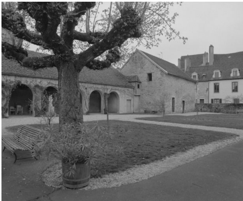
Ancienne sellerie du comte d'Armagnac, puis préau des orphelins.
