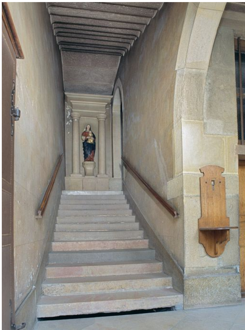
Bâtiment de la Communauté des soeurs et des orphelins, 1ère volée de l'escalier principal, vue prise de l'entrée. 21, Beaune, 3 rue Rousseau Deslandes
