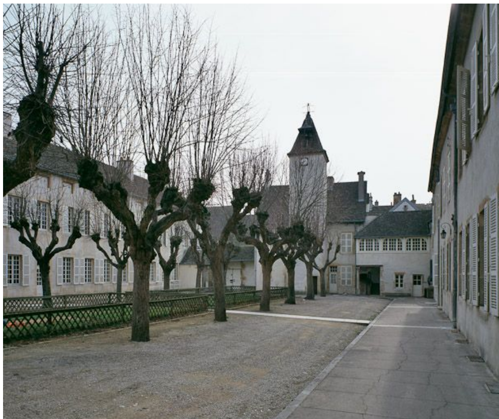
Vue d'ensemble des bâtiments entourant la cour principale.
