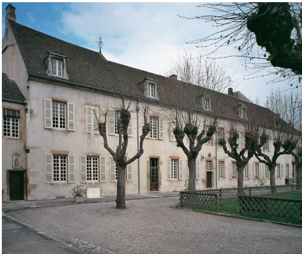
Bâtiment de la Communauté des soeurs et des orphelines, élévation est, sur cour. 21, Beaune, 3 rue Rousseau Deslandes
