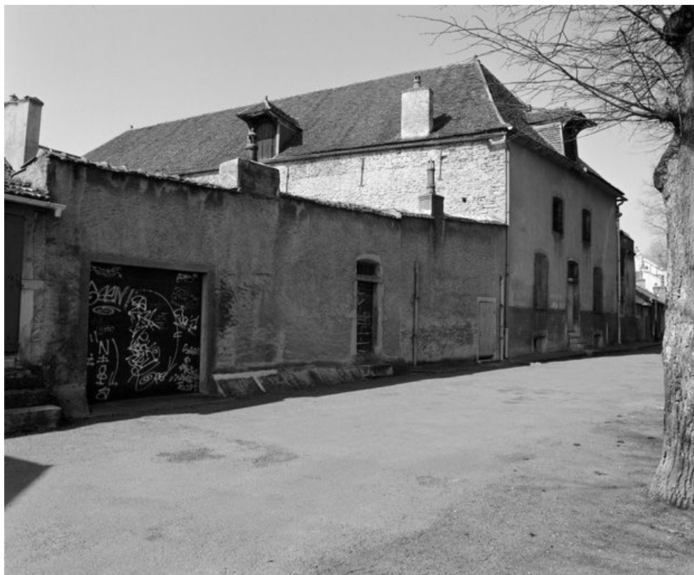
Vue d'ensemble depuis le rempart de La Comédie
