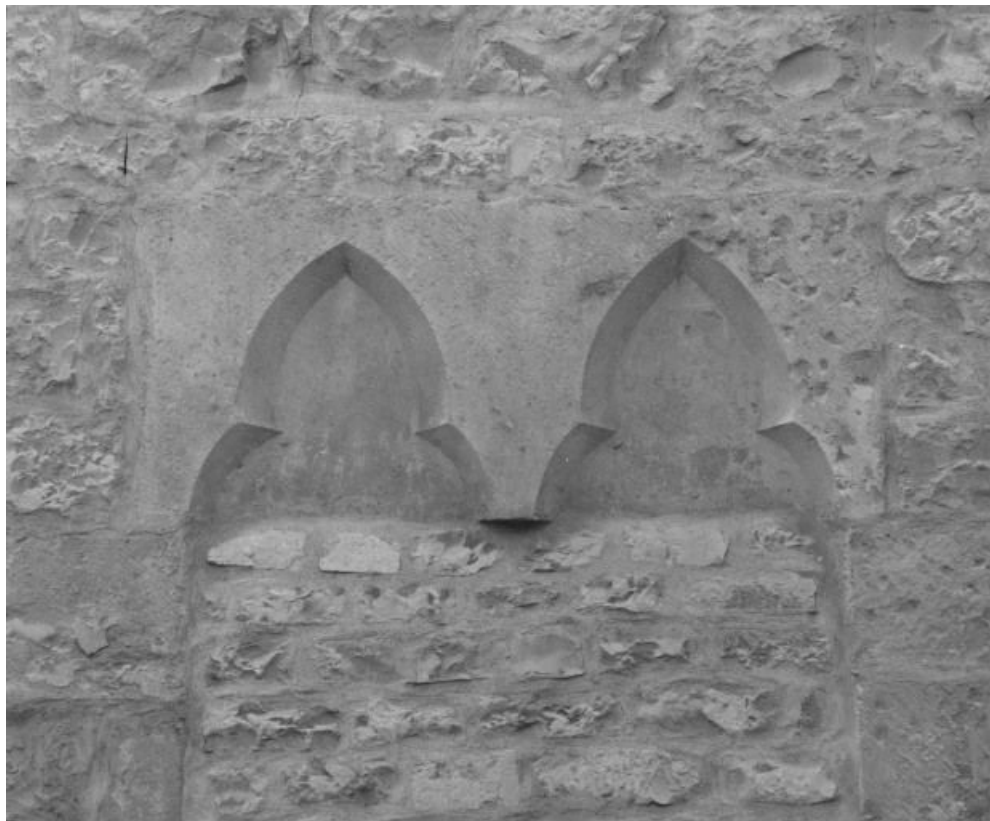
Bâtiment dit de l'administration : vestiges de baies jumelées murées (élévation droite sur la rue). 21, Nuits-Saint-Georges Henri-Challand
