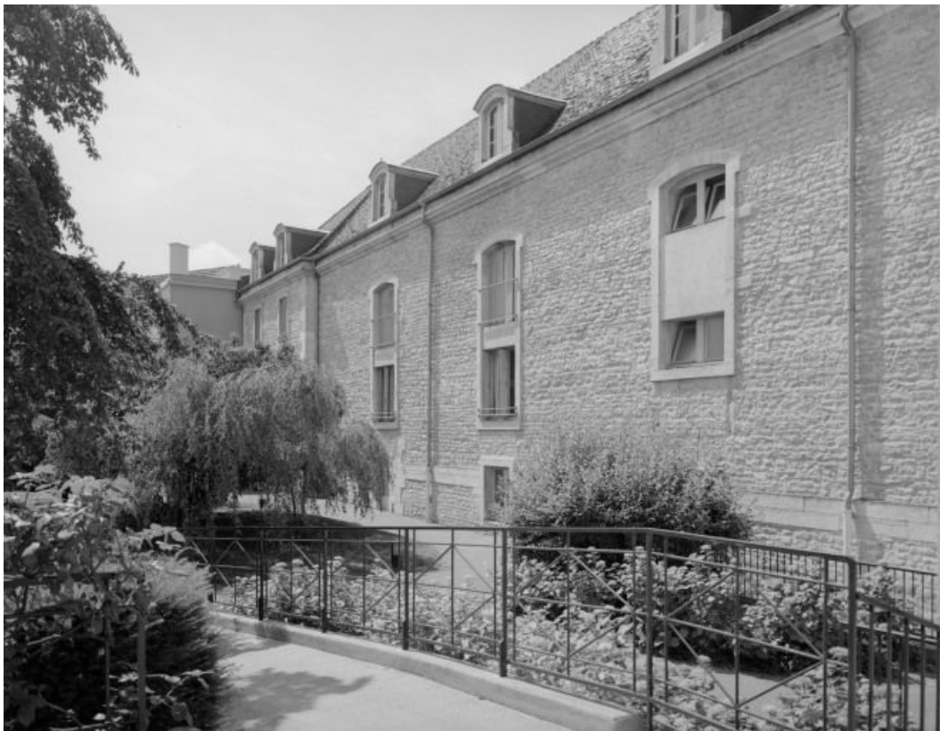
Salles Saint-Joseph et Saint-Etienne : élévation sur le jardin.
