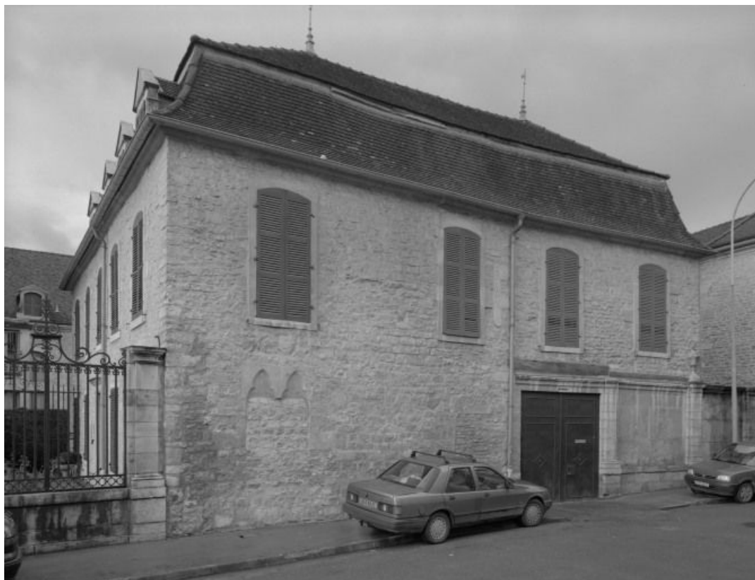
Bâtiment dit de l'administration : élévation droite sur la rue.
