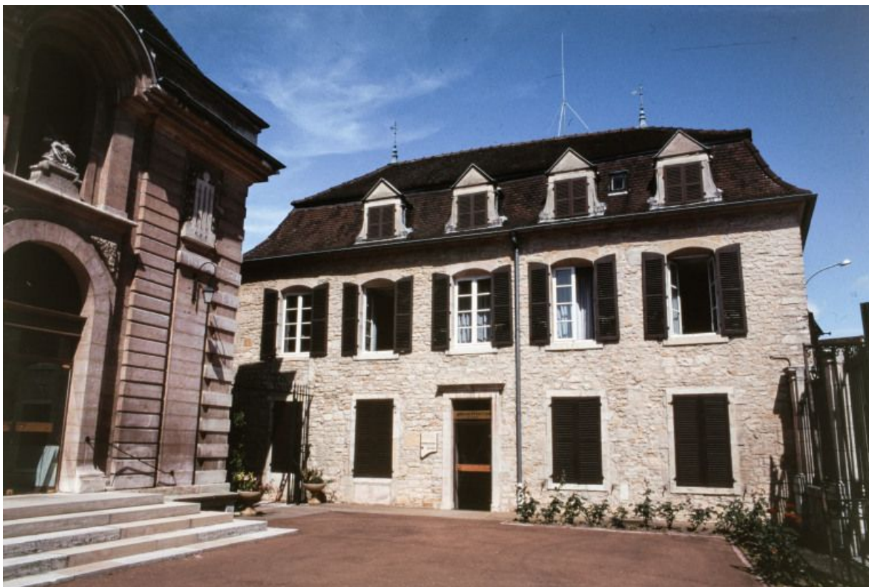
Bâtiment dit de l'administration : élévation antérieure.
