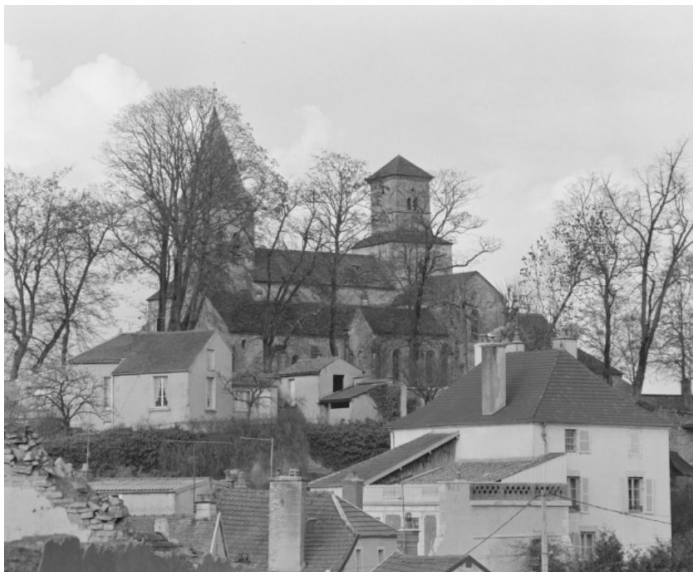
Vue d'ensemble du site, au sud
