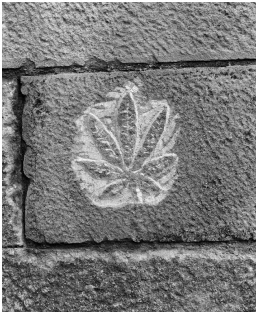
Façade : porche, feuille de marronnier sculptée sur le mur gauche (à l'extérieur) 21, Châtillon-sur-Seine espace Saint-Vorles
