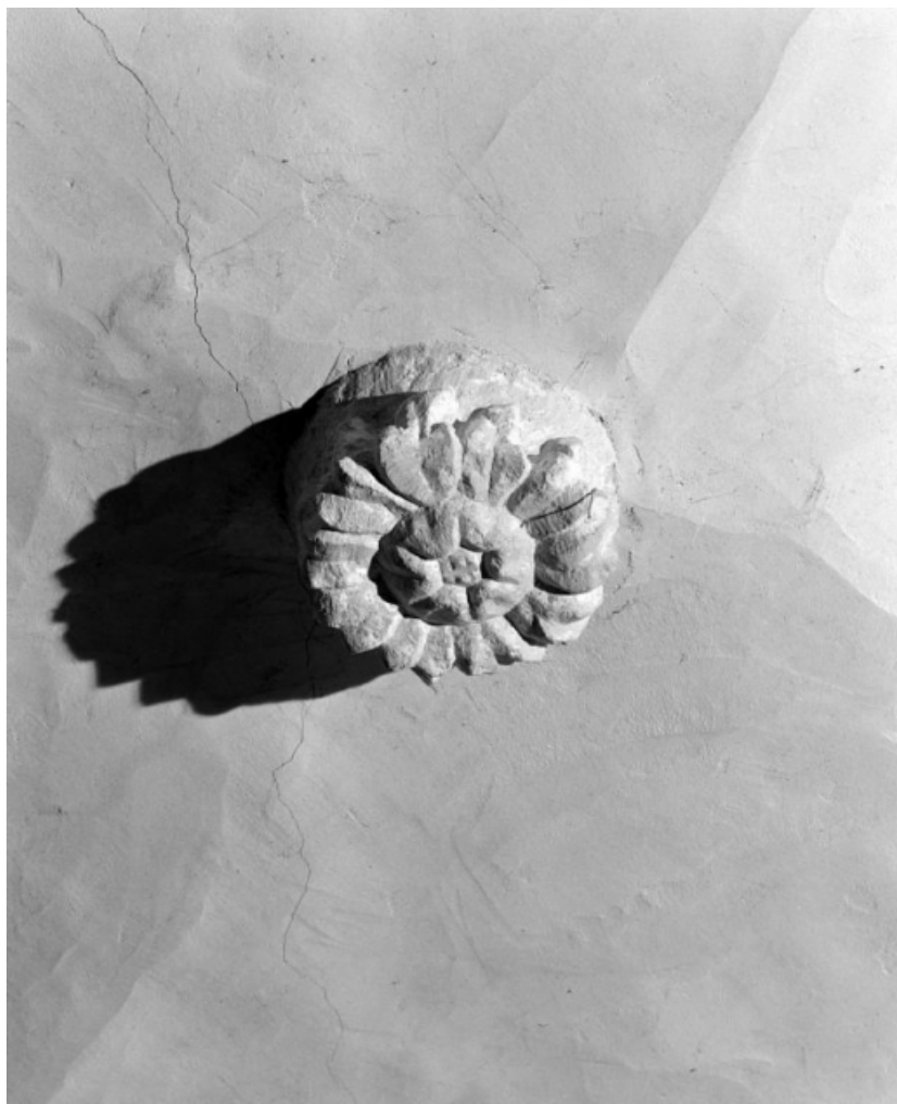
Sacristie : clef de voûte de la travée sud 21, Châtillon-sur-Seine espace Saint-Vorles
