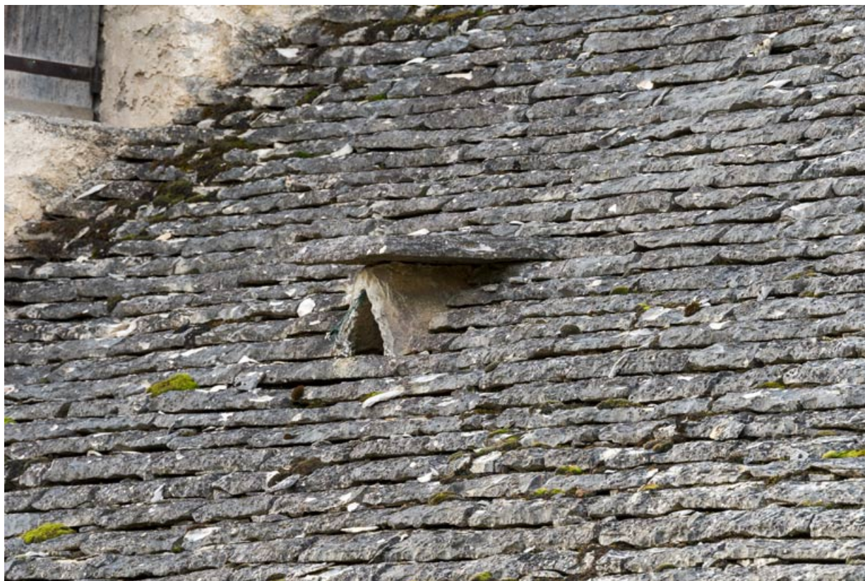
Détail de la toiture côté nord.
