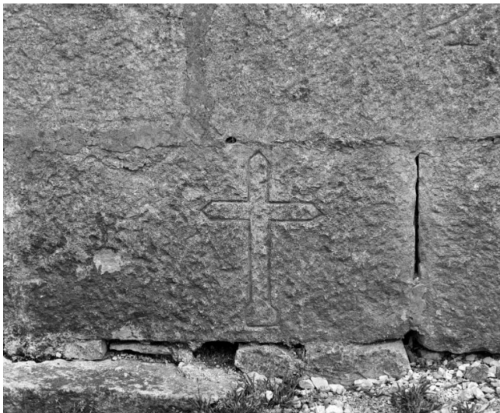
Façade : porche, croix gravée sur le mur droit 21, Châtillon-sur-Seine espace Saint-Vorles
