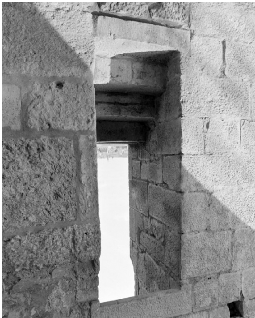
Façade : porche, vestiges d'escalier (mur gauche)
