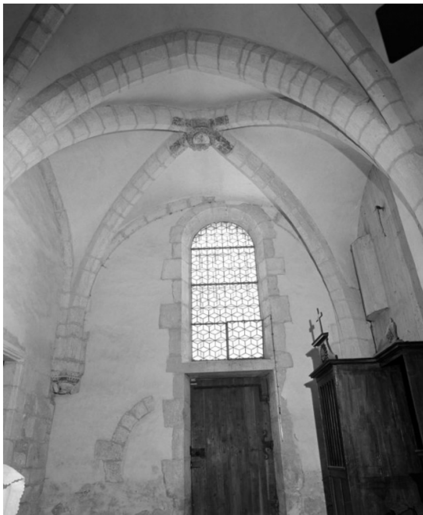
Chapelle du Rosaire : voûte de la travée sud 21, Châtillon-sur-Seine espace Saint-Vorles
