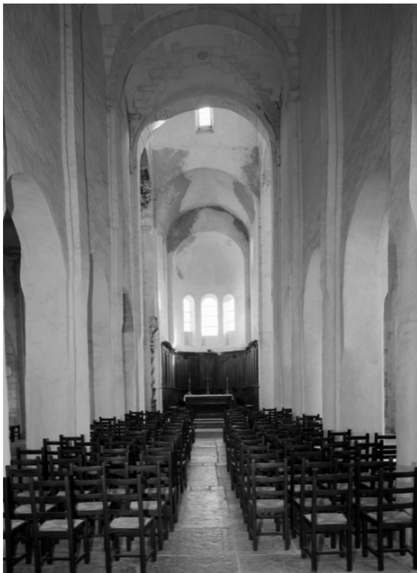
Nef et chœur : vue prise de l'entrée 21, Châtillon-sur-Seine espace Saint-Vorles
