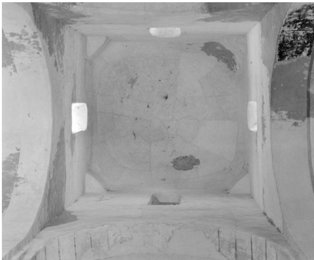
Croisée du transept : coupole à trompes 21, Châtillon-sur-Seine espace Saint-Vorles
