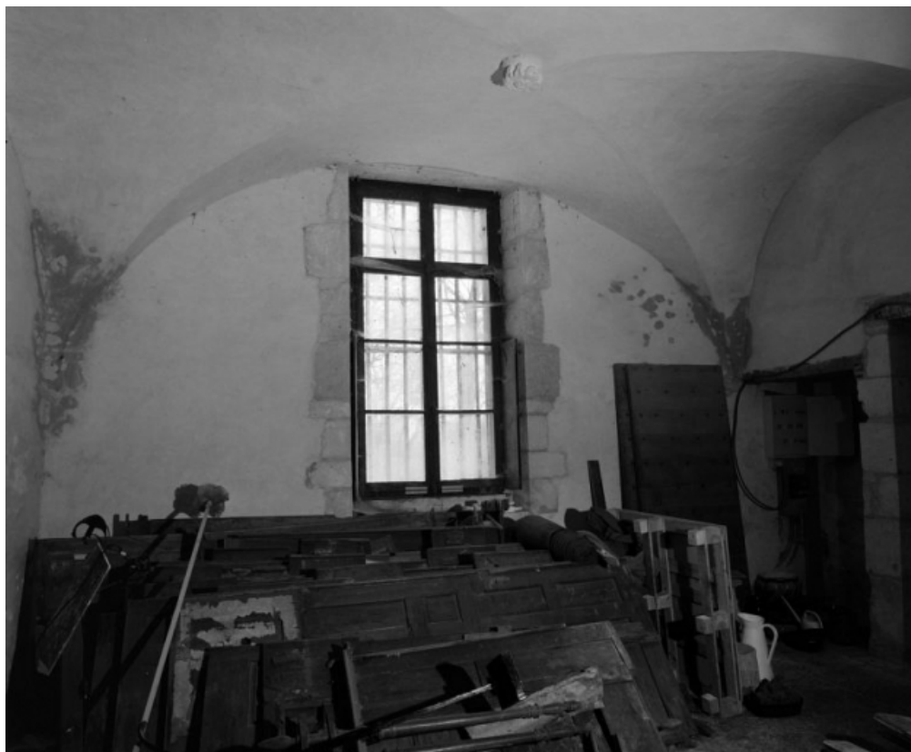
Sacristie : travée sud (vue prise du nord) 21, Châtillon-sur-Seine espace Saint-Vorles
