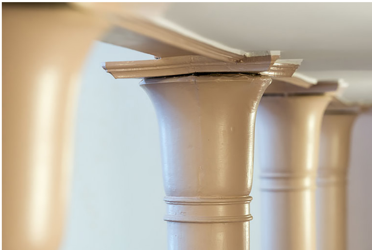
Aile nord, salle de spectacle : chapiteaux de colonnes du rez-de-chaussée. 21, Châtillon-sur-Seine place de la Résistance
