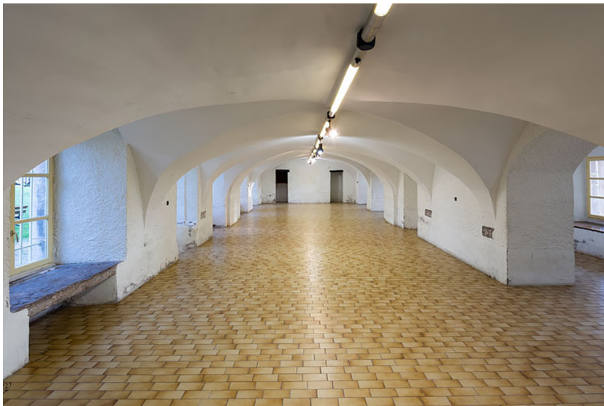
Aile est : salle voûtée au rez-de-chaussée ("salle des Bénédictines"). 21, Châtillon-sur-Seine place de la Résistance
