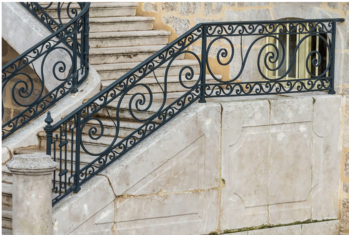
Aile est, façade antérieure : escalier, rampe d'appui de la volée de droite. 21, Châtillon-sur-Seine place de la Résistance
