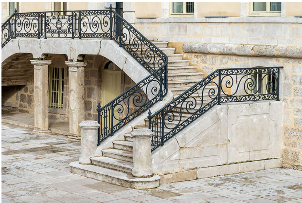
Aile est, façade antérieure : escalier, volée de droite.
