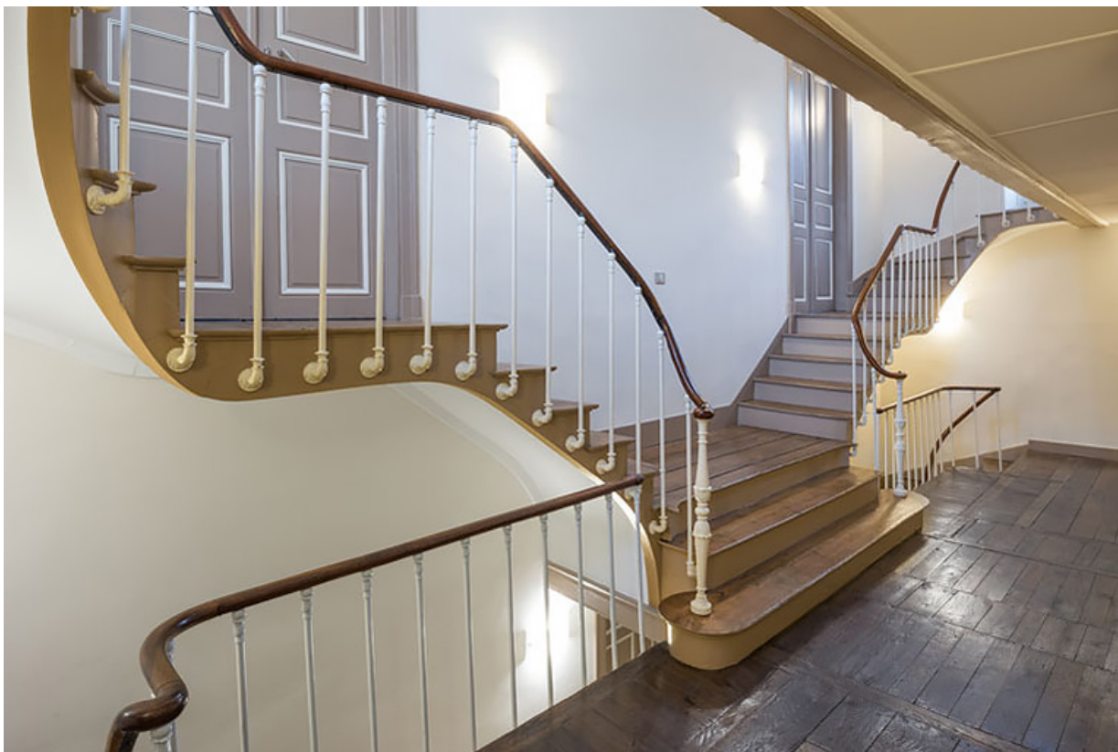
Aile nord, salle de spectacle : escalier au 1er palier.
