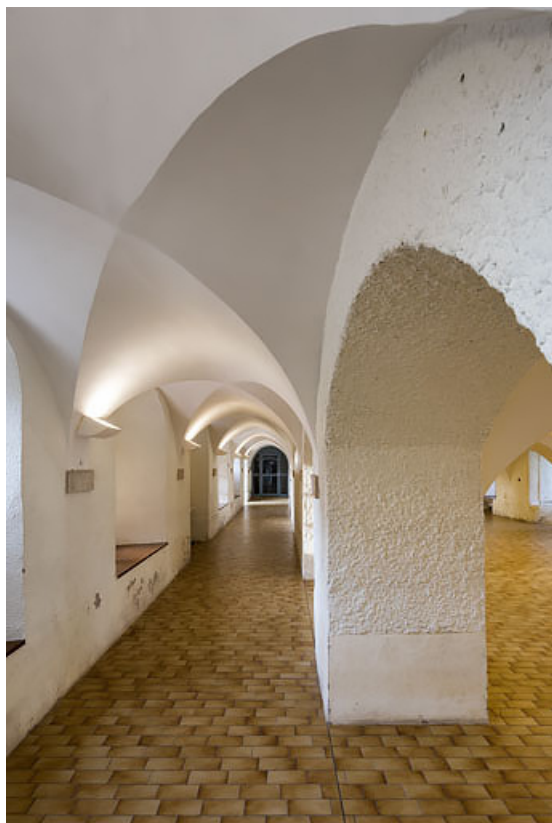
Aile est : couloir voûté desservant le rez-de-chaussée. 21, Châtillon-sur-Seine place de la Résistance
