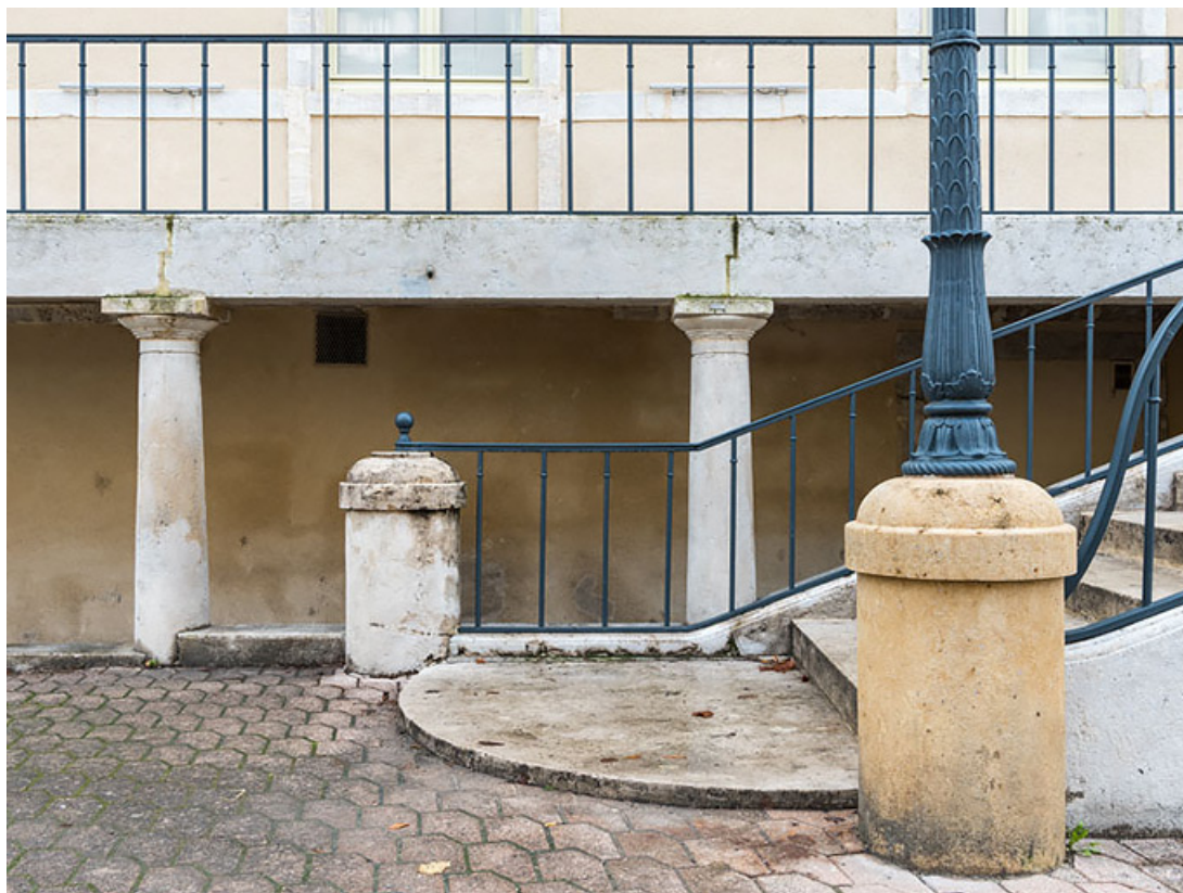
Aile nord, façade antérieure : départ de l'escalier et colonnes doriques supportant le balcon. 21, Châtillon-sur-Seine place de la Résistance
