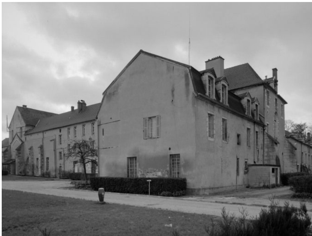
Bâtiment conventuel : élévations postérieure et latérale.
