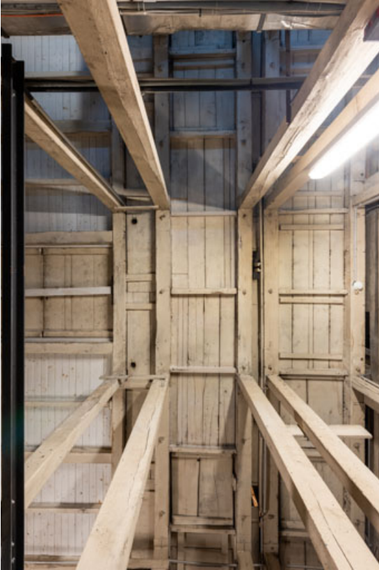
2e dessous : plancher du 1er dessous, montrant rues et costières (fentes permettant le passage des châssis). 21, Dijon place du Théâtre
