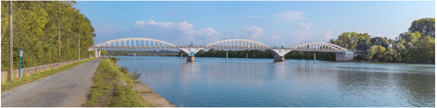
Le pont de Thoissey, vu d'amont depuis la rive gauche. En arrière-plan, le barrage de Dracé. 01, Thoissey route départementale 7, lieudit : PK 63,37
