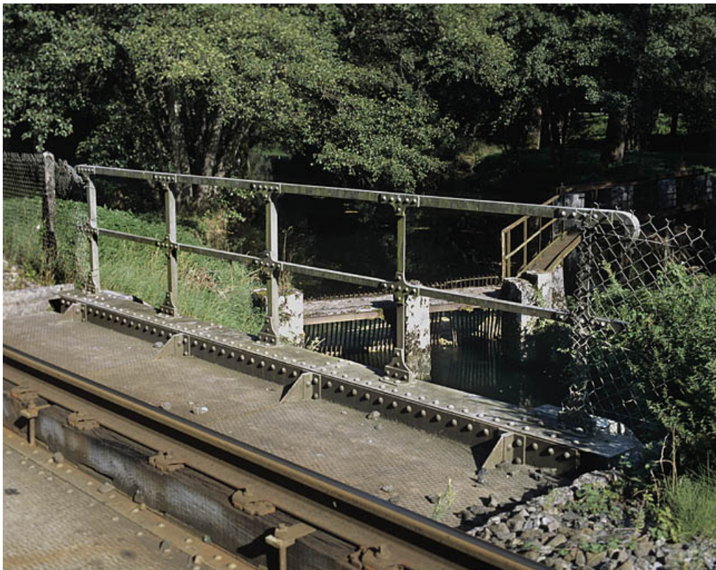
Pont : garde-corps. À l'arrière-plan, prise d'eau et vannage.
