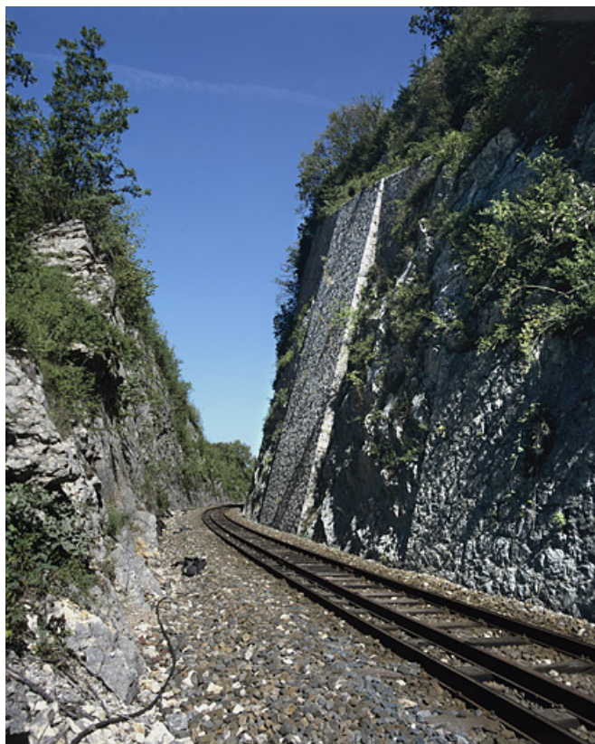
Vue d'ensemble, depuis le côté La Cluse (sud-ouest).
