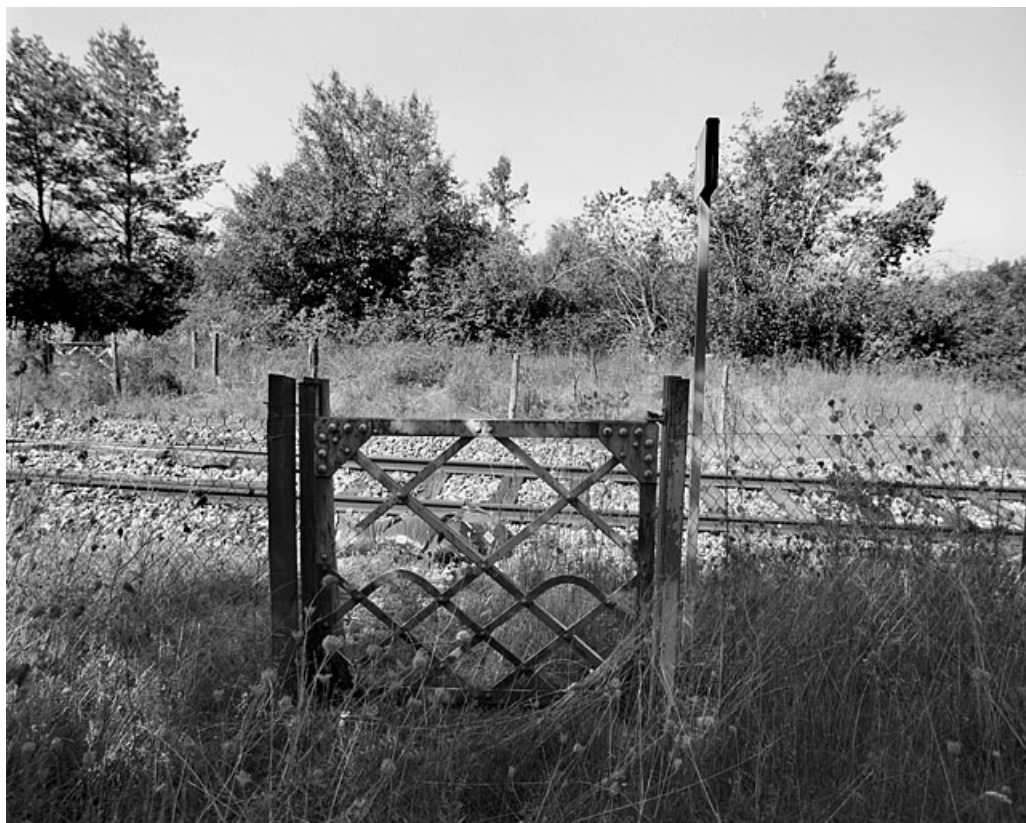
Portillon pour piétons, côté droit de la voie : vue d'ensemble.
