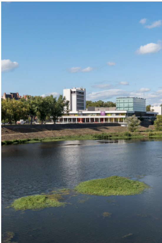
Vue d'ensemble, depuis le sud (cadrage vertical).
