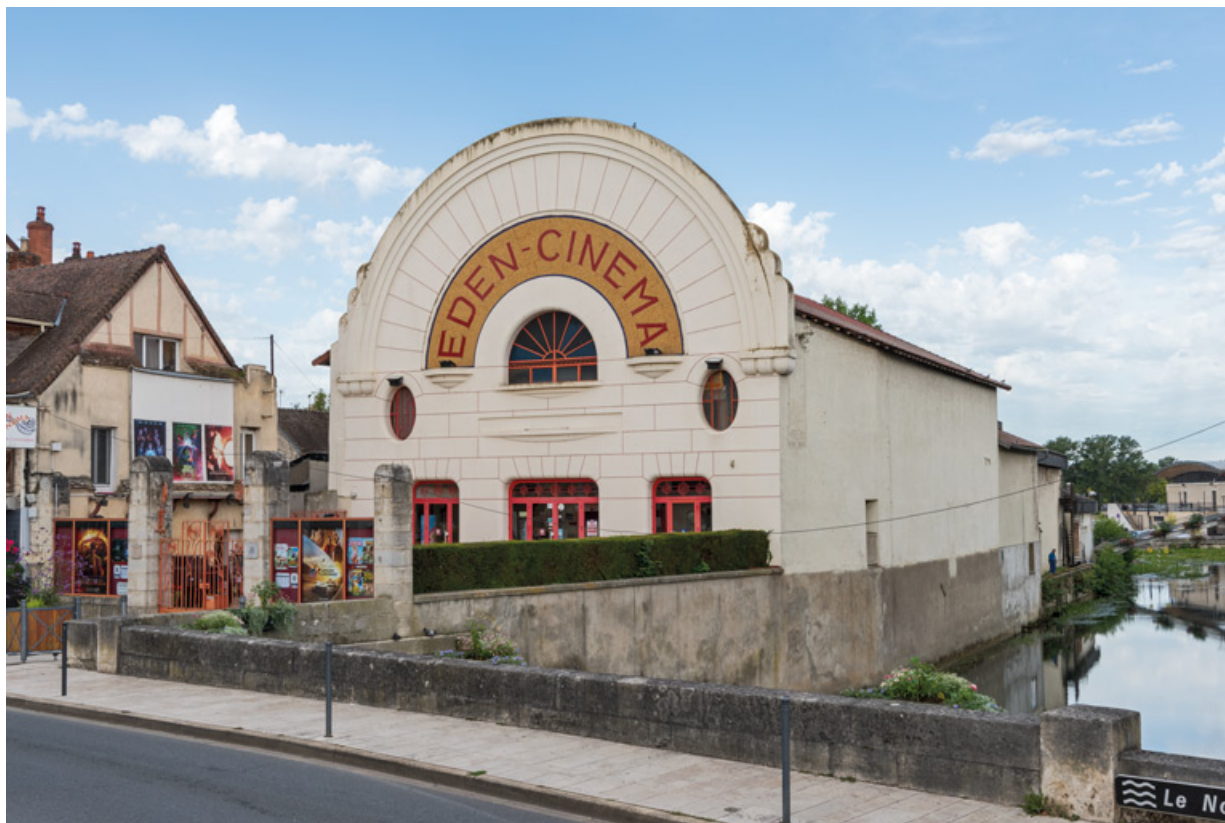
Façades antérieure et latérale droite : cinéma.
