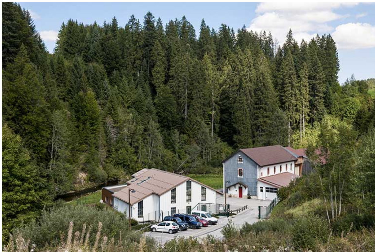
Vue plongeante depuis le sud-ouest.
