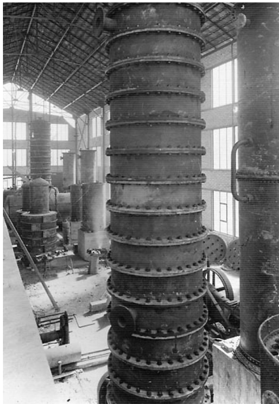
Intérieur de la raffinerie. Colonnes de distillation.
