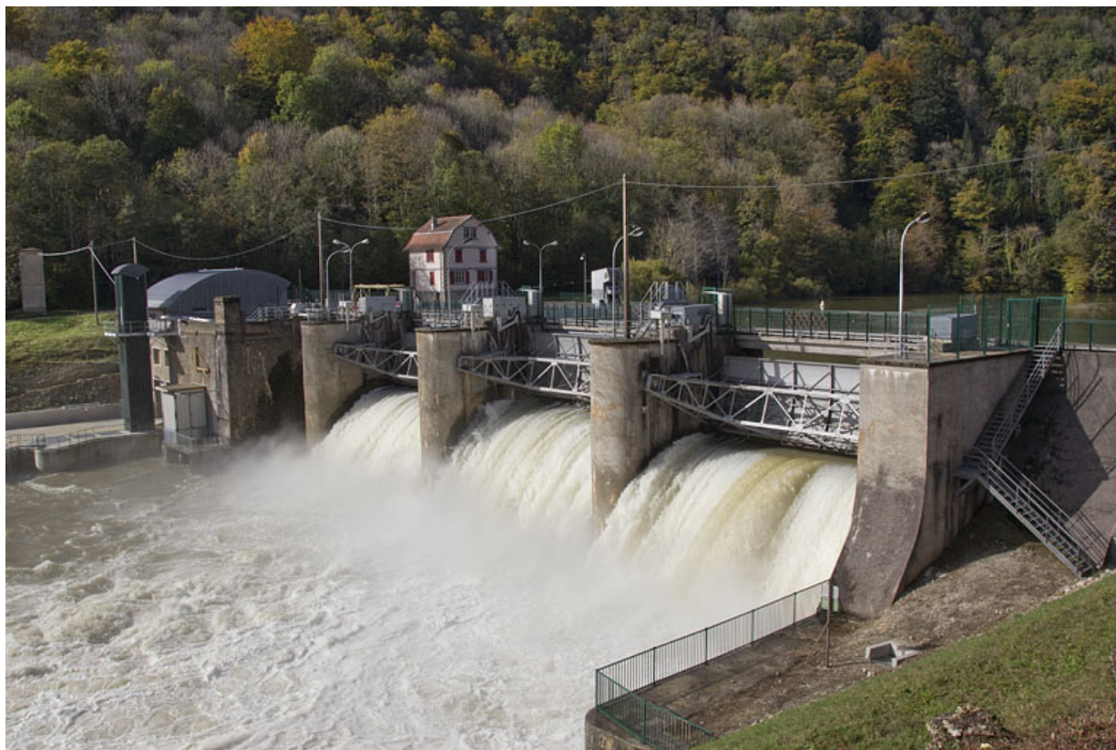
Vue d'ensemble depuis le sud-est, en période de crue.
