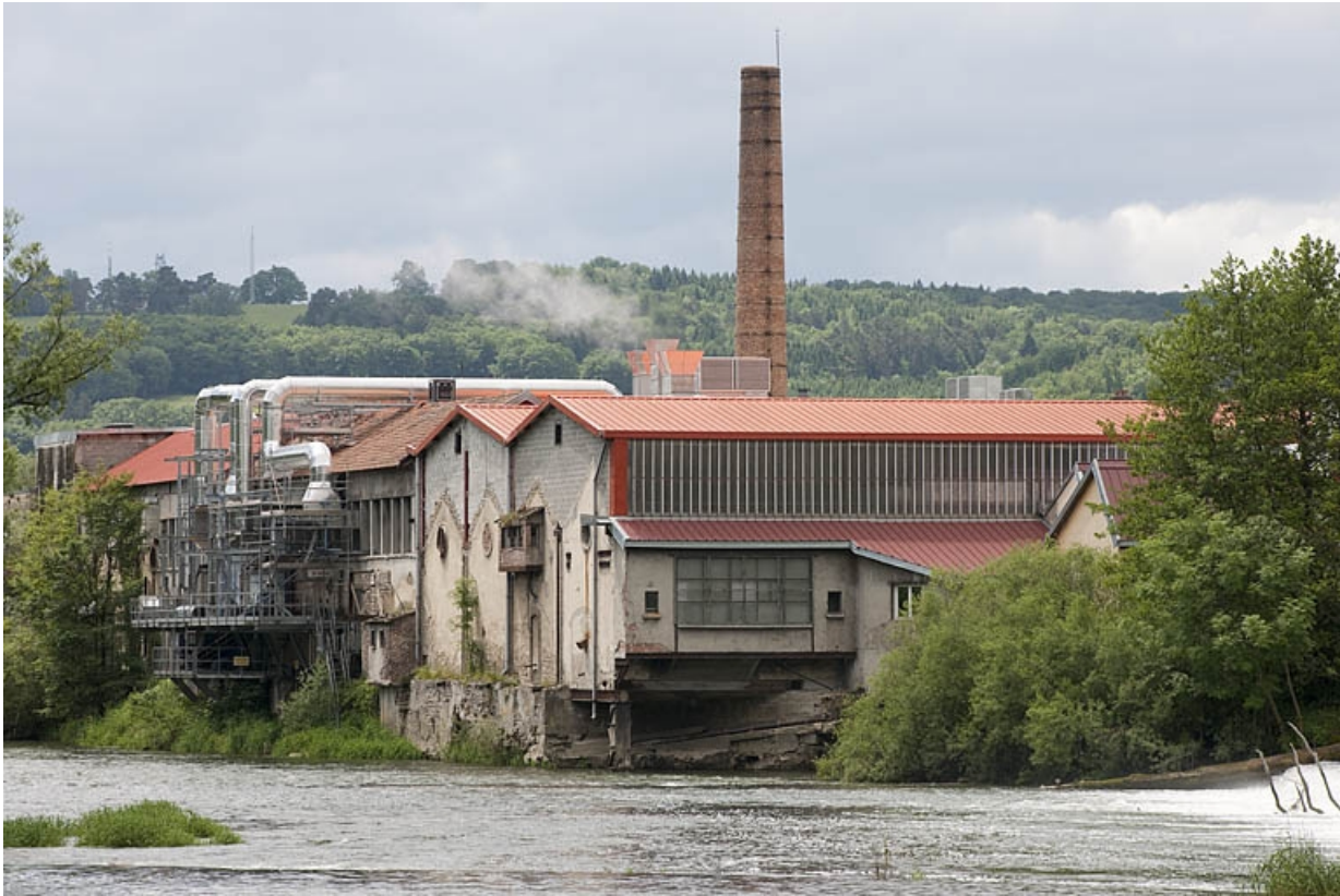
Bâtiments industriels depuis le nord.
