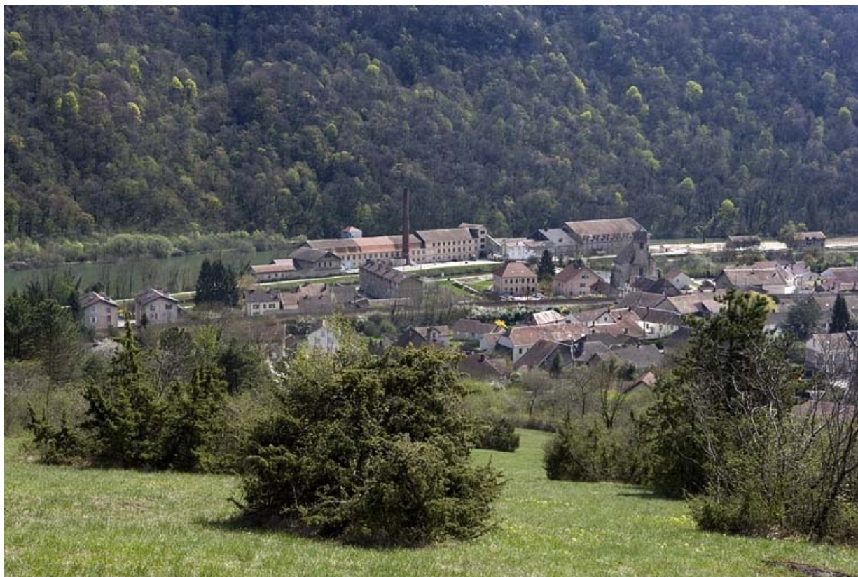
Vue d'ensemble depuis l'ouest.
