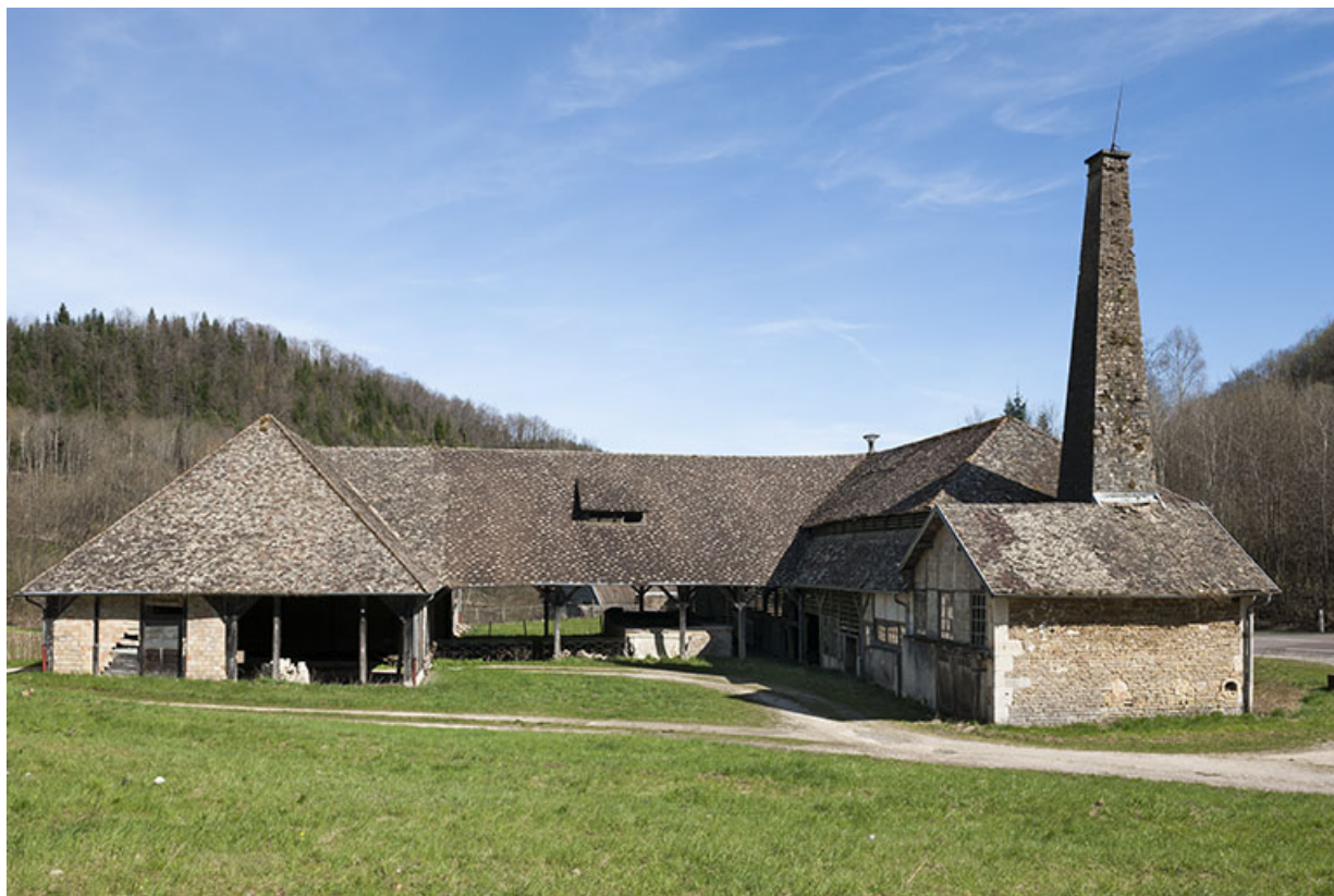
Vue rapprochée depuis l'ouest.
