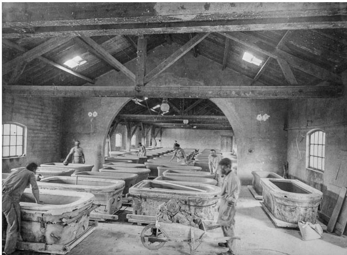
Le moulage des baignoires (bâtiment 42).
