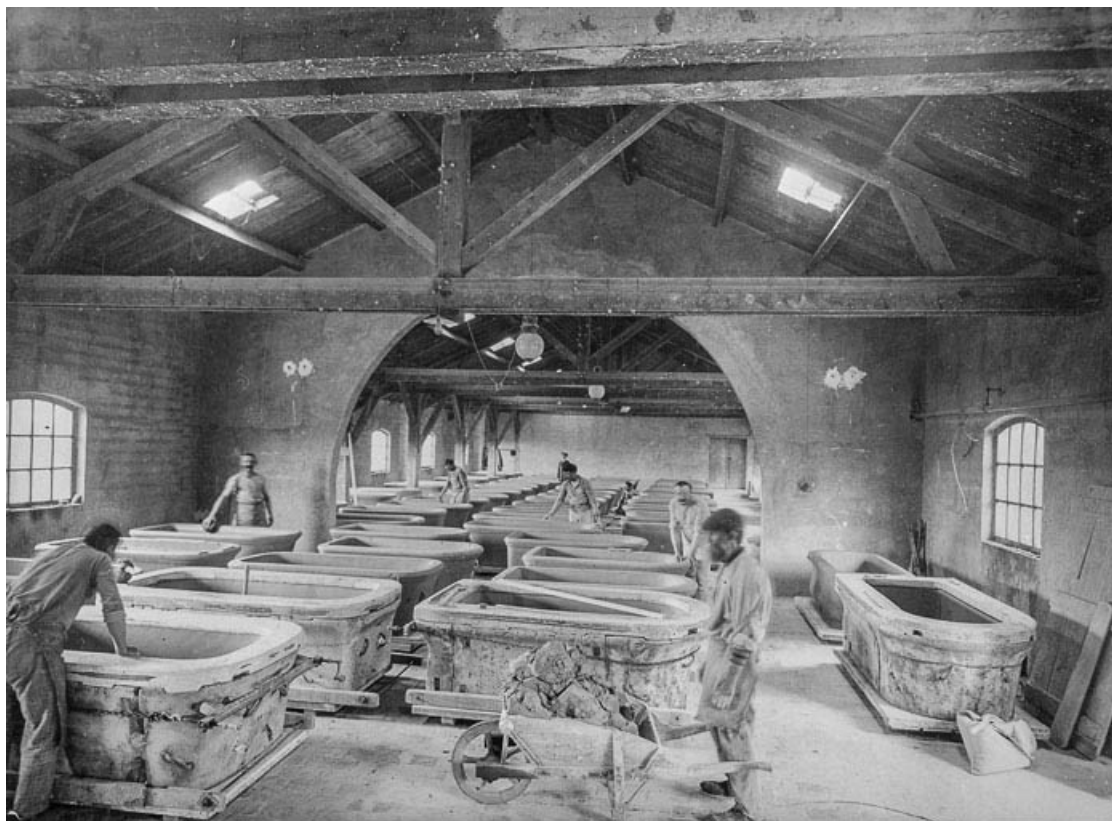
Le moulage des baignoires (bâtiment 42).
