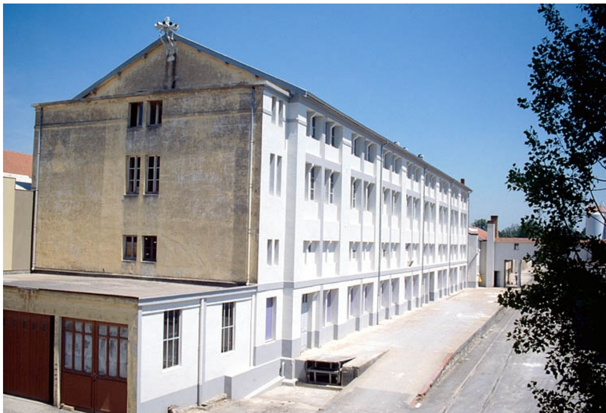
Atelier de coulage des moules (42), vu de trois quarts gauche.
