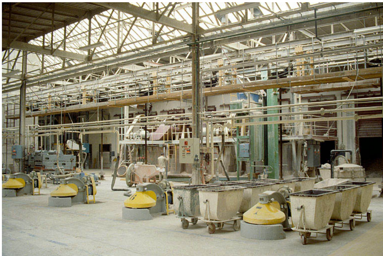
Atelier de préparation de la pâte (9), intérieur.
