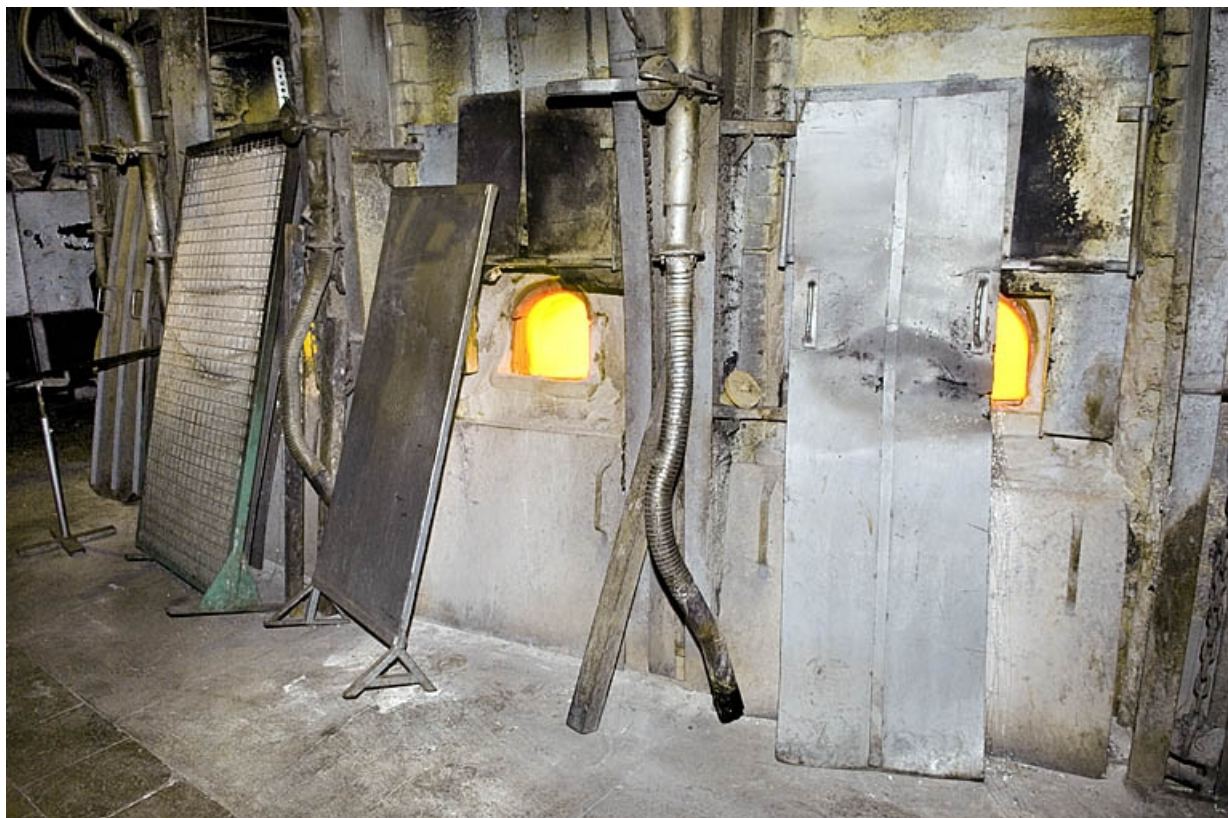
Atelier verrerie main. Four à pots.
