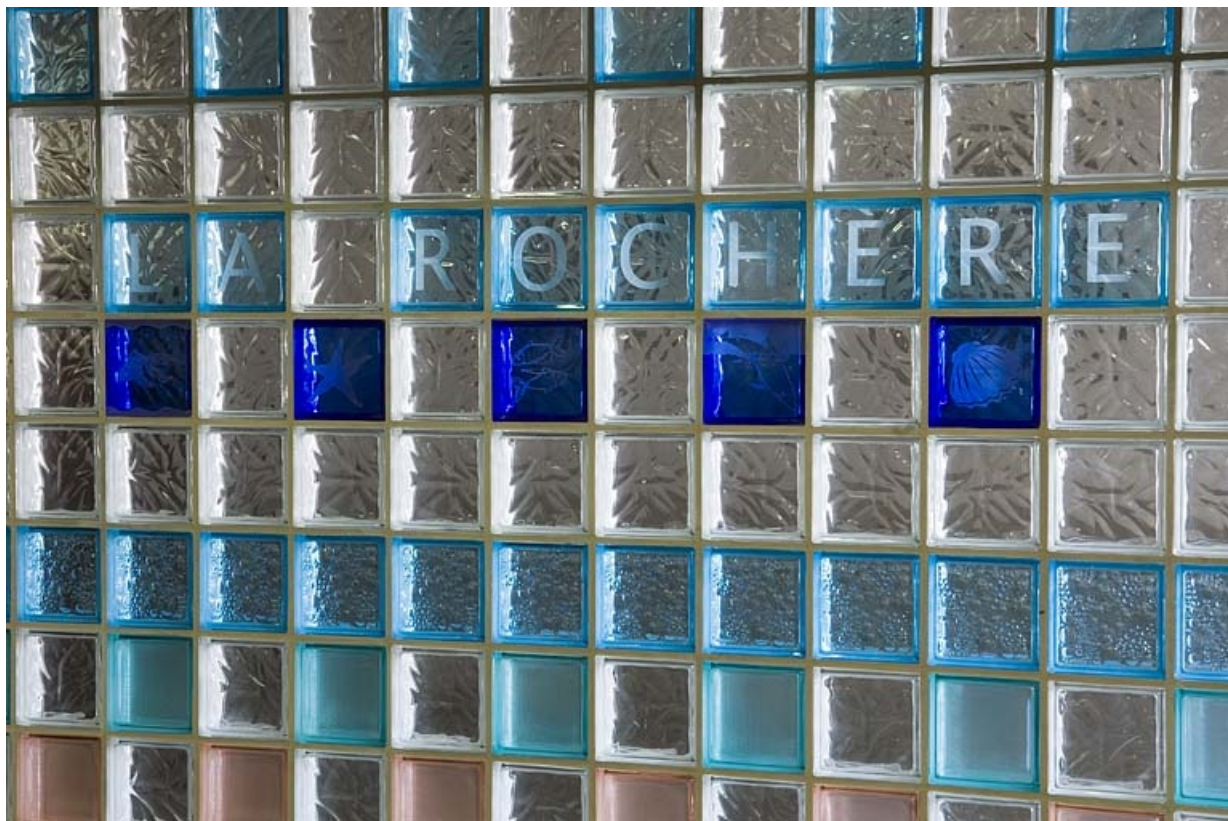
Atelier des fours. Cloison en pavés de verre.
