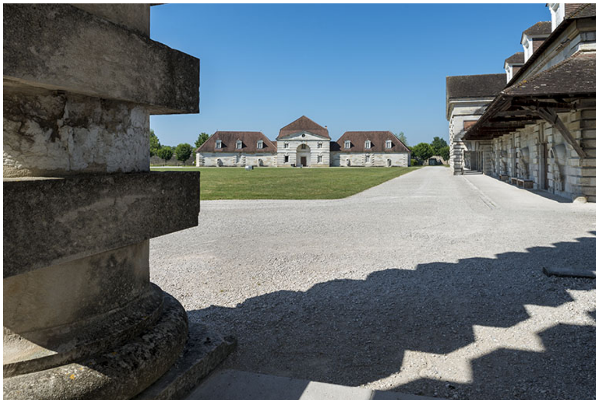
Logement des ouvriers et berne ouest depuis la maison du directeur.
