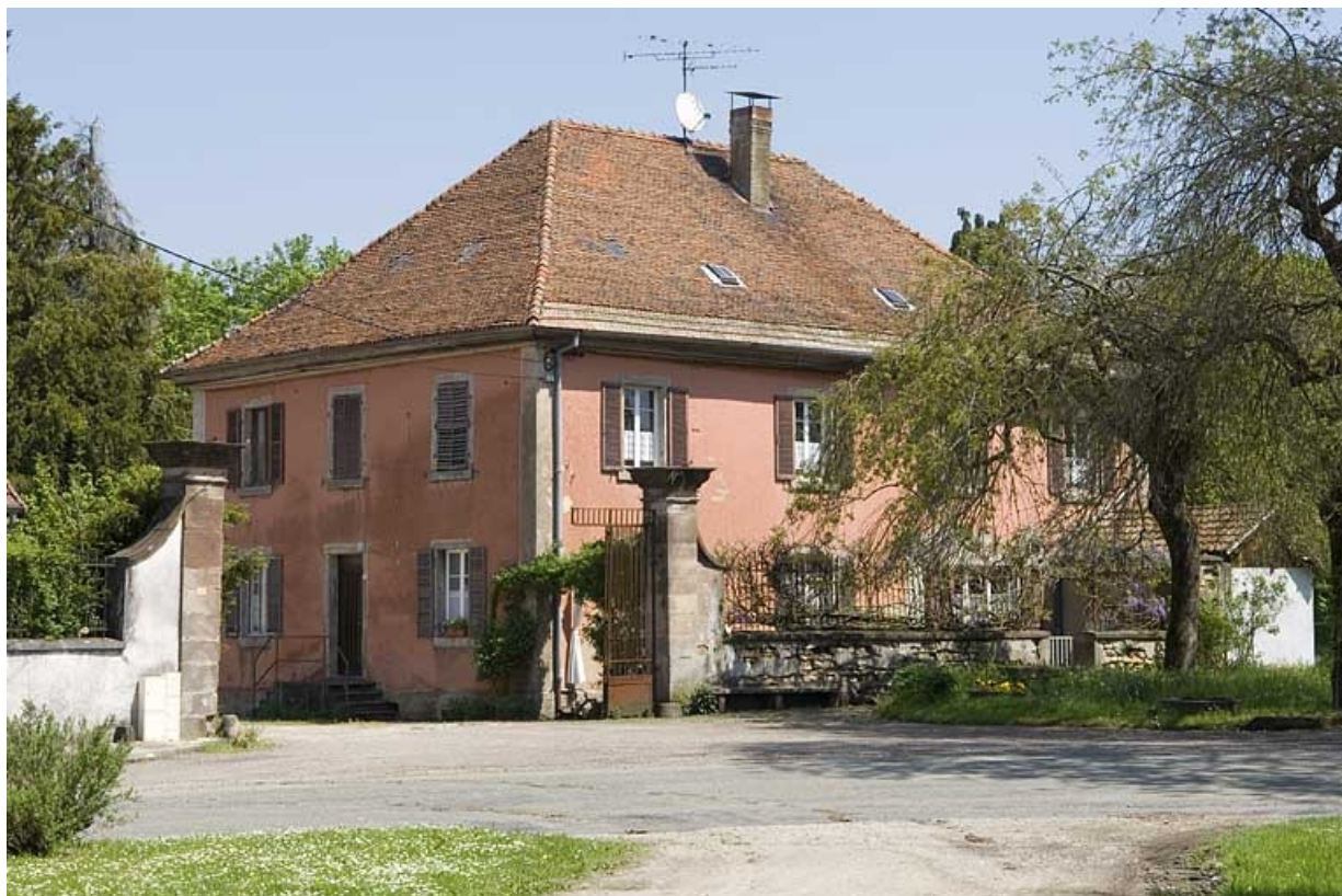
Bâtiment des bureaux (direction).
