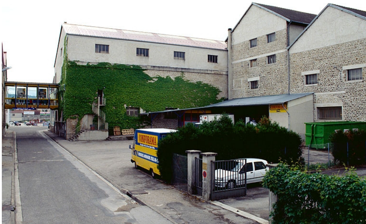
Atelier de fabrication depuis le nord-ouest.
