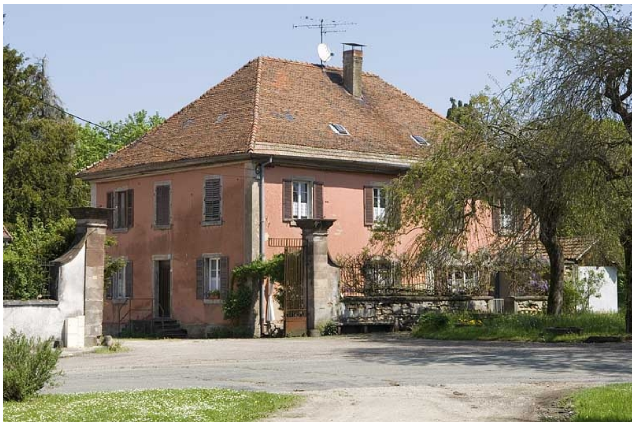
Bâtiment des bureaux (direction).
