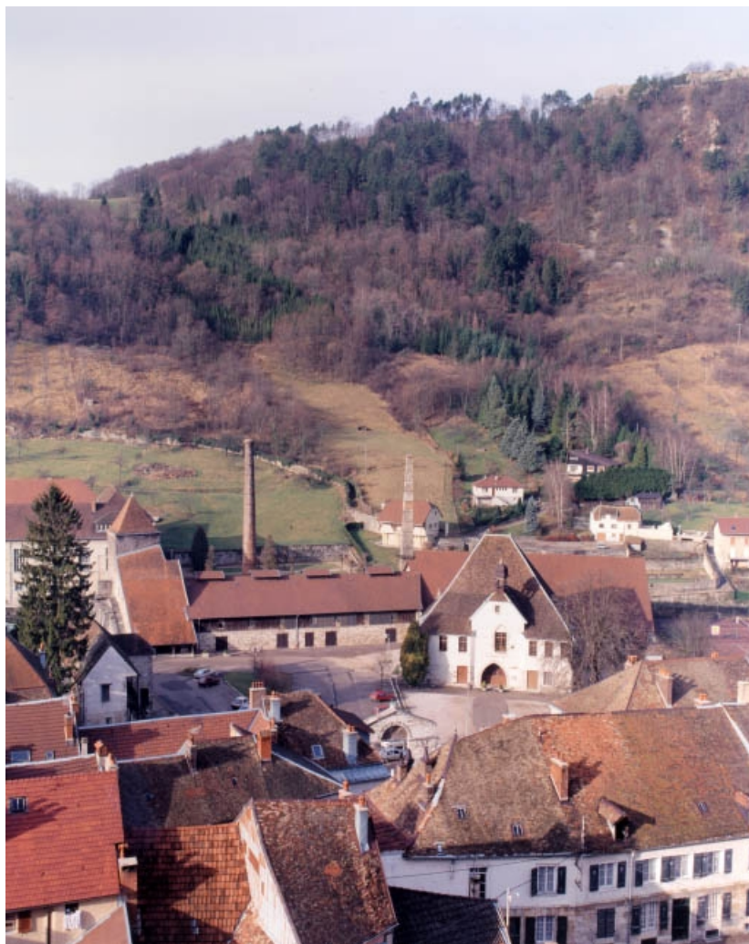
Vue d'ensemble depuis l'est : logement du Pardessus et bâtiment des poêles. 39, Salins-les-Bains place des Salines
