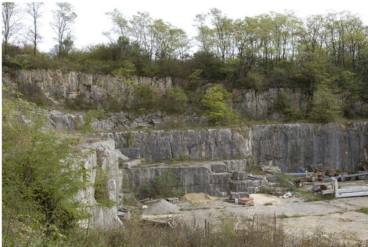
Vue d'ensemble plongeante sur le front de taille.
