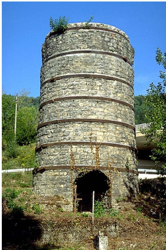
Four à chaux.
