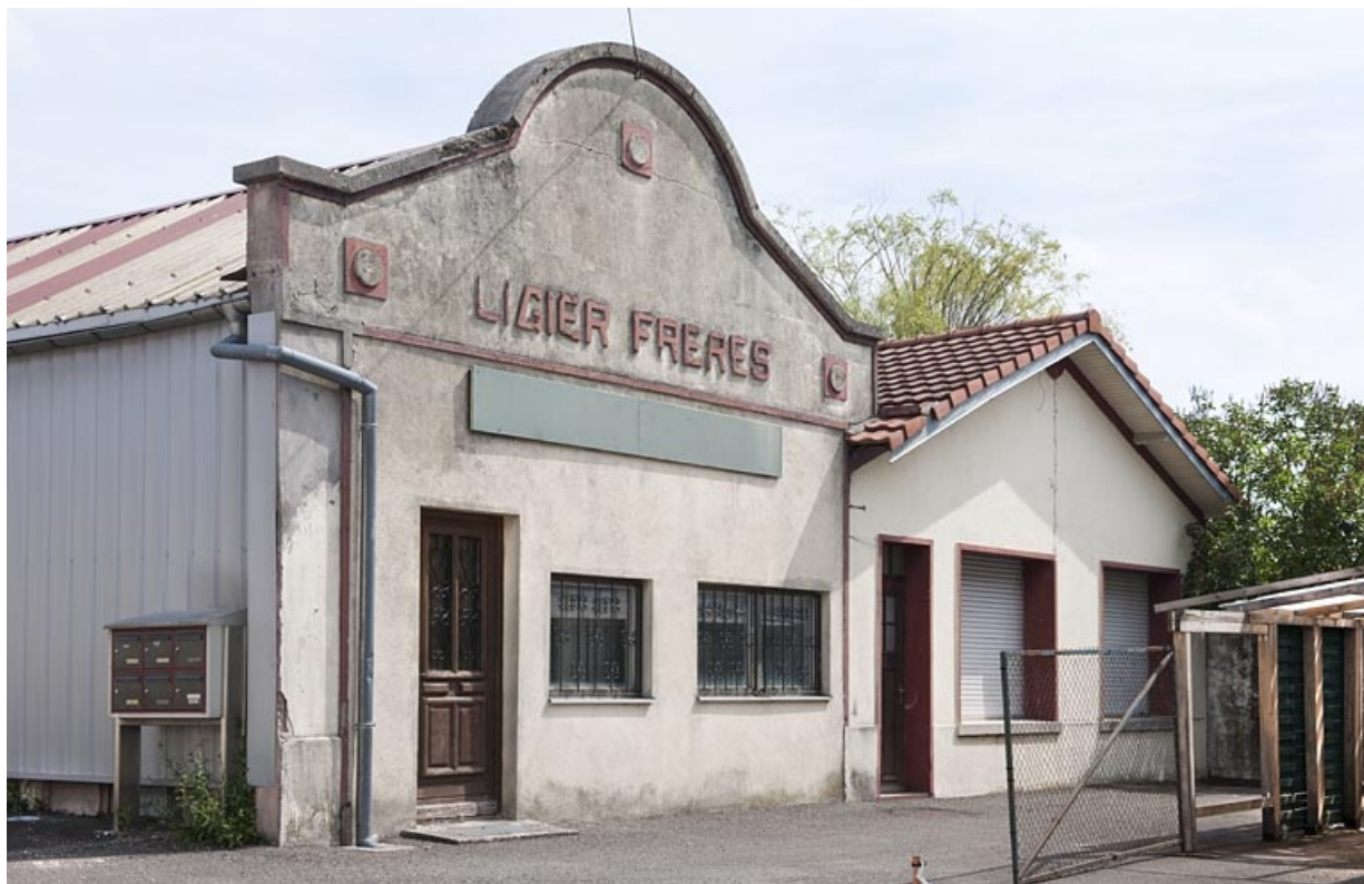
Pignon de l'atelier de fabrication originel.
