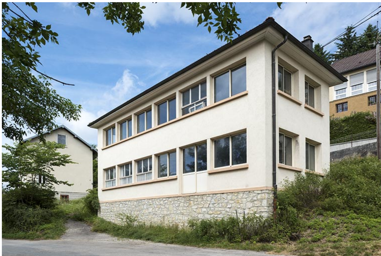
Façades postérieure et latérale gauche.
