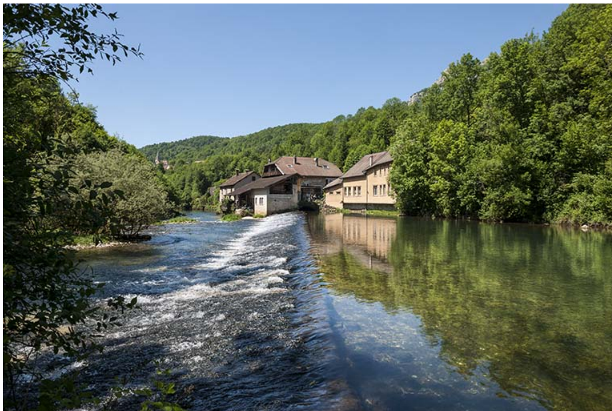
Vue d'ensemble depuis le barrage, en amont.
