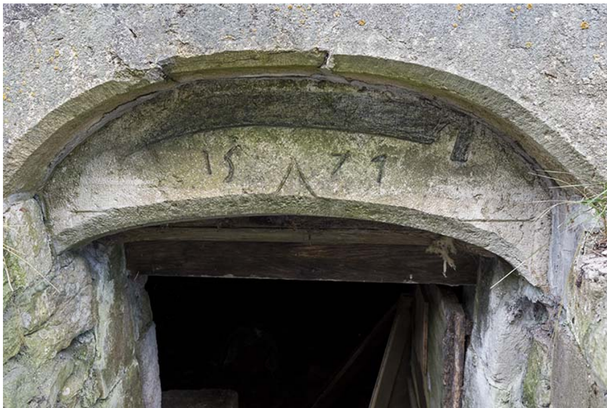
Façade est : linteau de l'entrée de la cave, avec date et dessin d'une faux. 25, Les Gras
