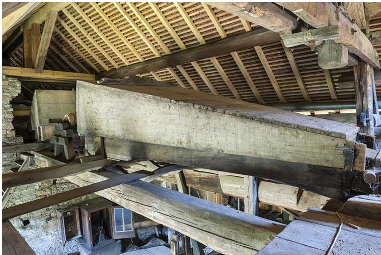
Caissons de la machine soufflante.
