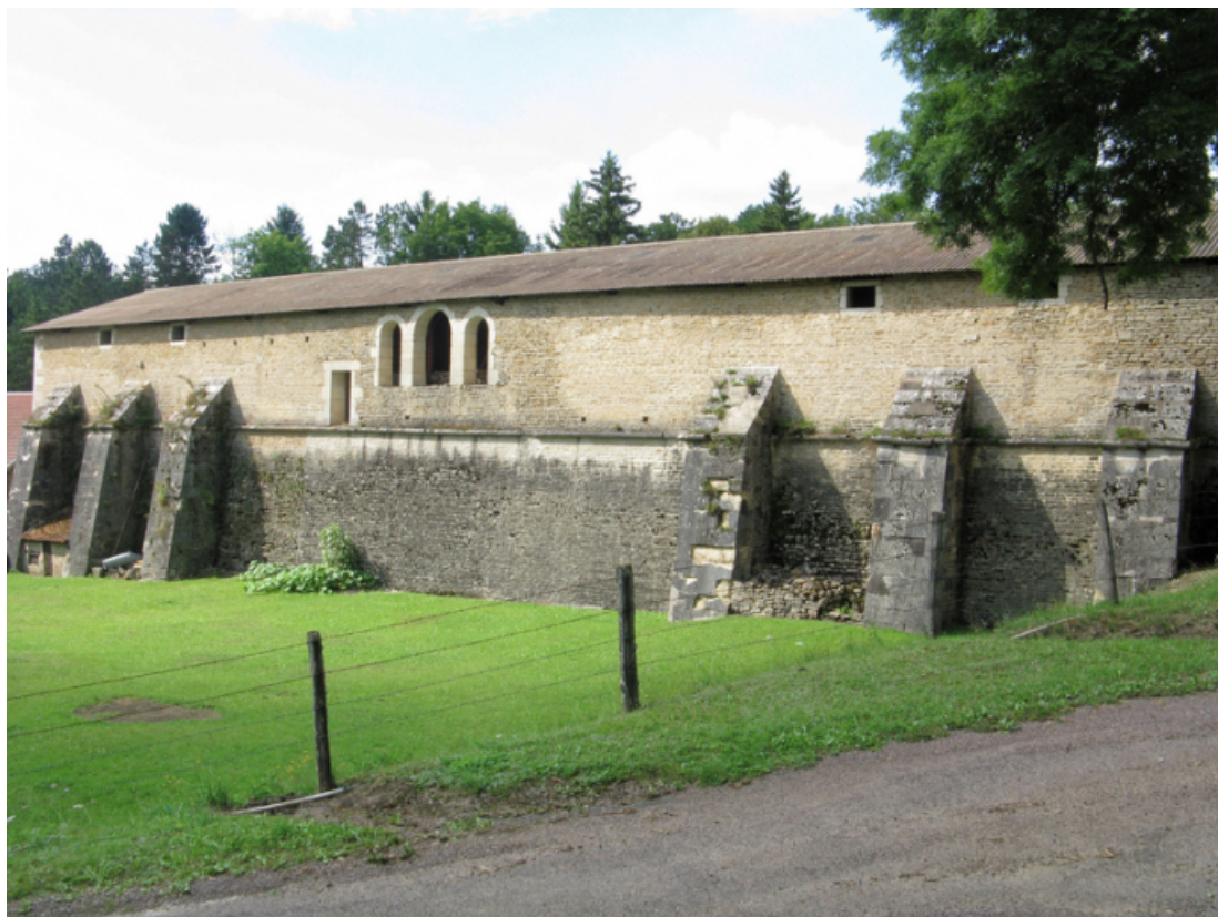
Ancienne halle du fourneau de la Thuillière (Auberive).
