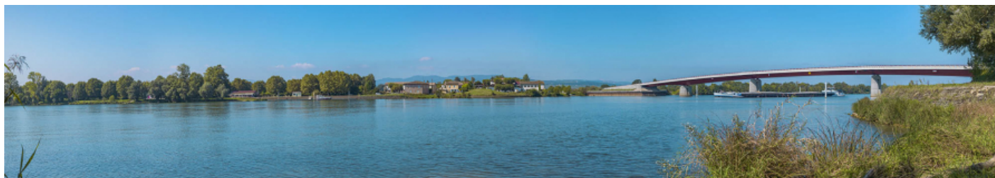
Vue d'ensemble du port et du pont d'Arciat, depuis la rive gauche de la Saône.
