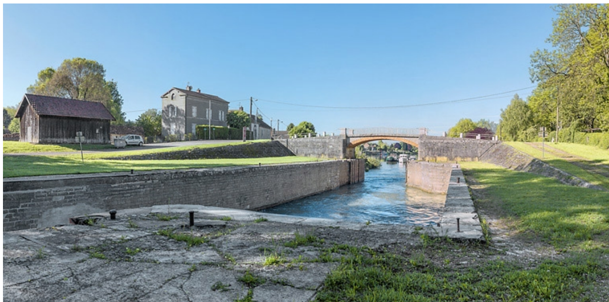
Vue d'ensemble du site : à gauche, la maison éclésièrè et au centre, le sas et le pont sur écluse.
