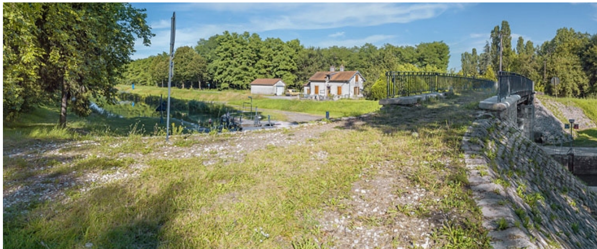
Vue d'ensemble. La maison éclusière en arrière-plan.
