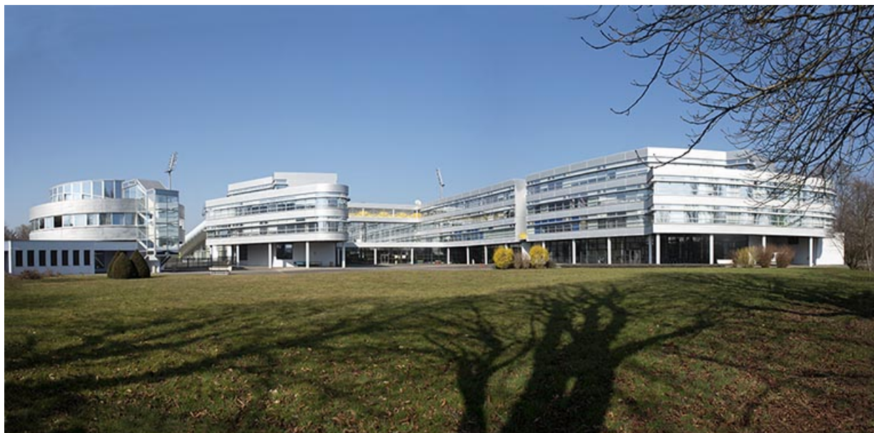
Belfort, lycée Gustave Courbet : vue d'ensemble depuis le sud.
