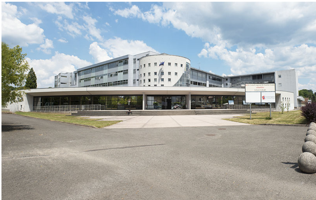
Lure, lycée Georges Colomb : place-parvis et façade de l'entrée.
