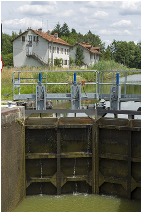
Ecluse n°44 : détail intérieur de la porte amont fermée et vue sur les cités, Demangevelle (70).
