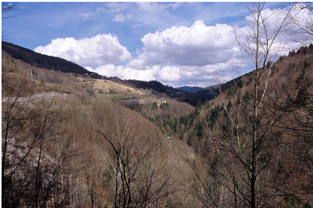
Voie ferrée dans la zone Tancua - Lézat : implantation dans la vallée de la Bienne. PK 052.000 à 058.000.
