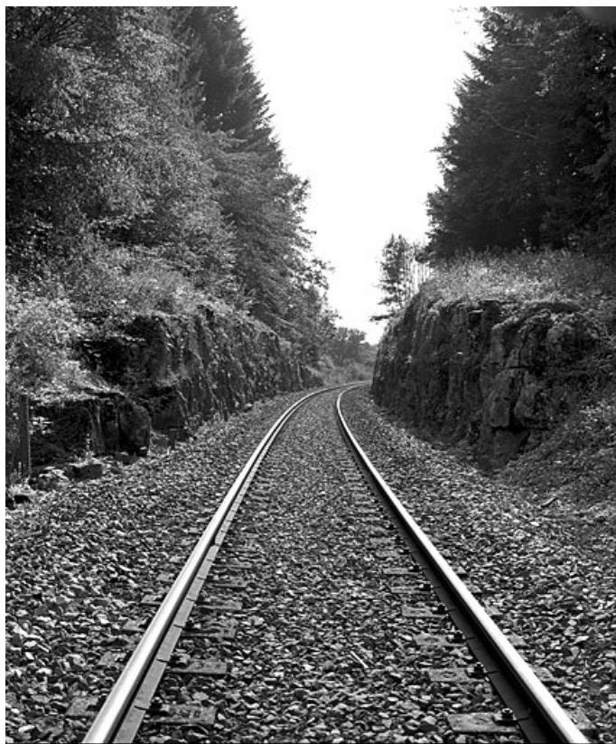
Vers-en-Montagne : tranchée proche de la maison de garde-barrière n° 1. Tranchée au PK 005.050.
