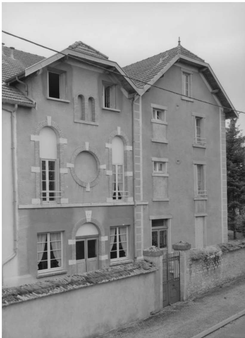
Bâtiment principal, élévation sur rue 21, Bézouotte CD 25b
