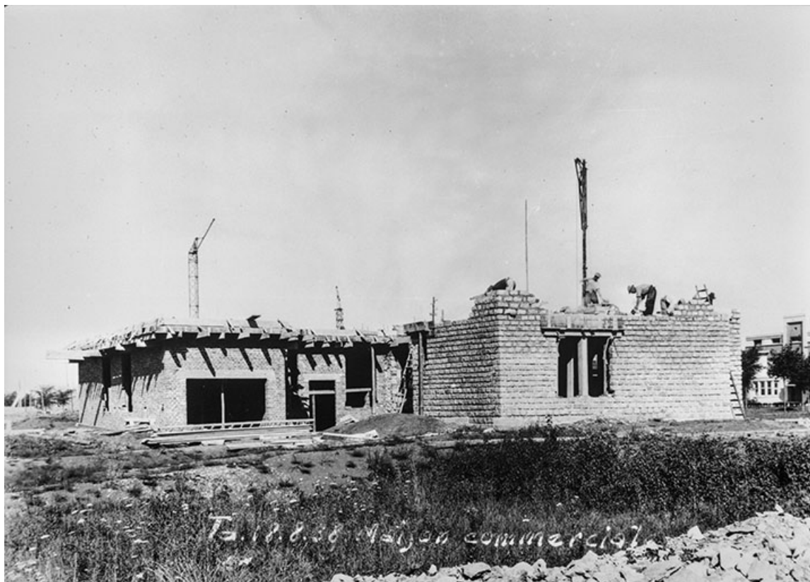
Travaux de construction de l'immeuble avec boutiques, 2, place de la Victoire, façade postérieure et face gauche. 39, Tavaux, lieudit : Tavaux Cité
