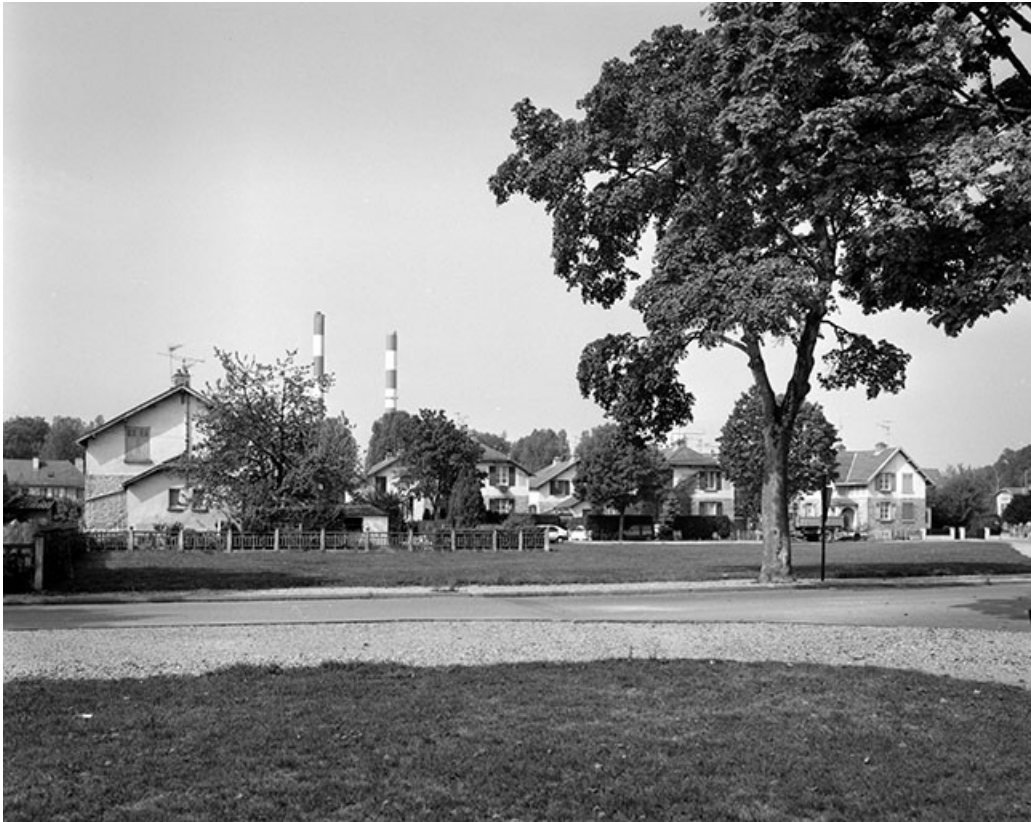
Vue d'ensemble des groupes V et W depuis la place de la Paix.
