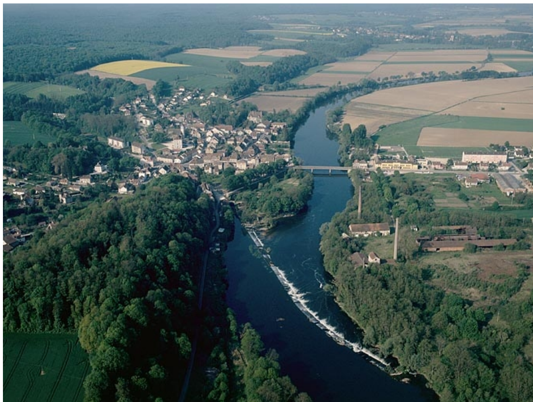
Vue d'ensemble du village et du site industriel depuis le nord-est, photographie aérienne.
