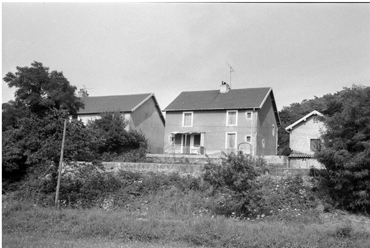
Façade postérieure de la "Caserne" (A, B).
