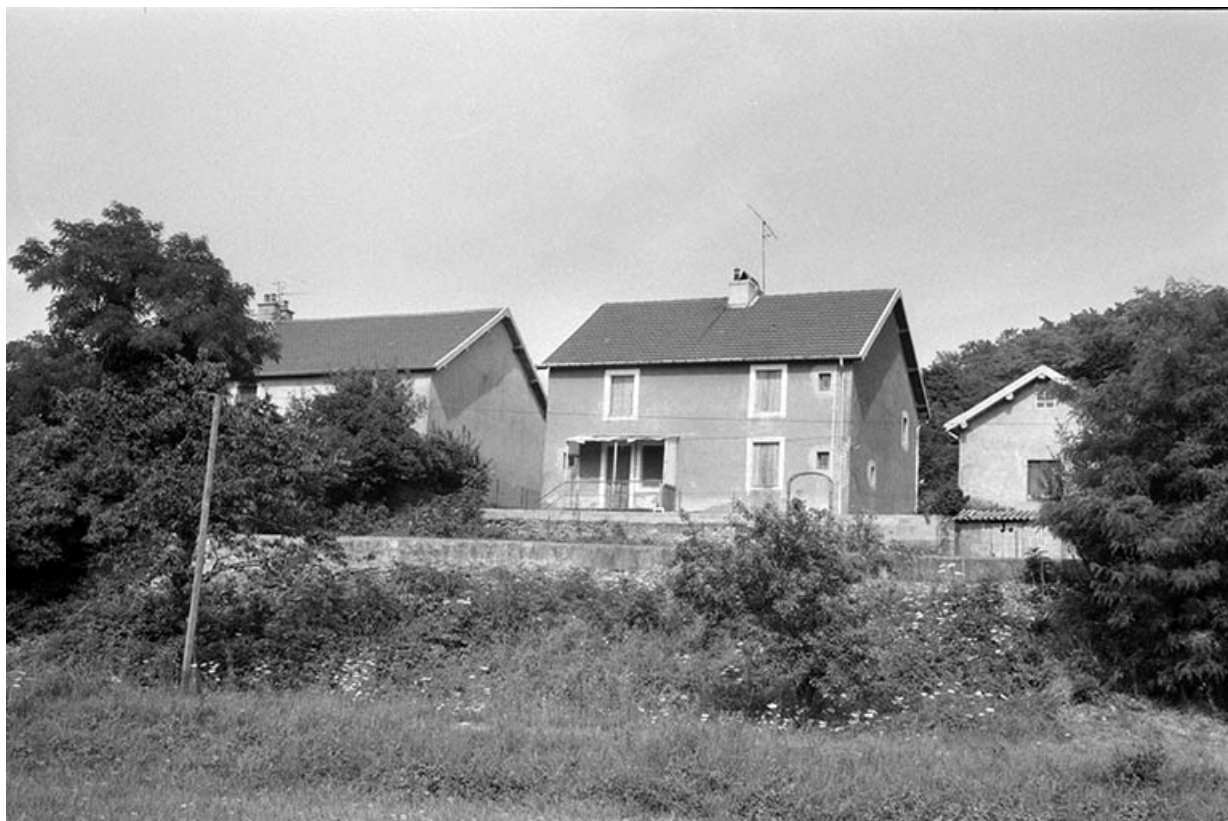
Façade postérieure de la "Caserne" (A, B).
