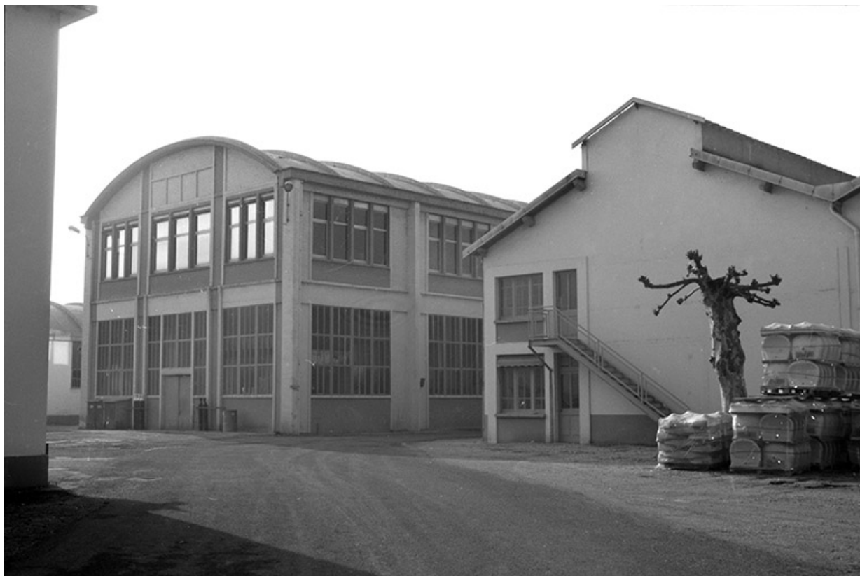
Magasin industriel (3) et atelier de réparation (5), vus de trois quarts droit.
