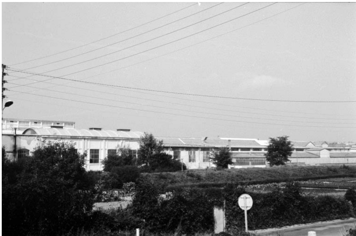
Salle des machines (10) et atelier de fabrication (9), depuis l'est. 39, Dole, 65 rue de Crissey
