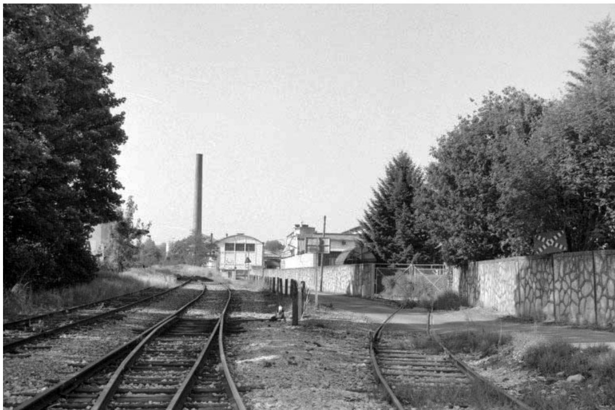
Salle des machines (10) et atelier de fabrication (9), depuis la voie ferrée au nord. 39, Dole, 65 rue de Crissey
