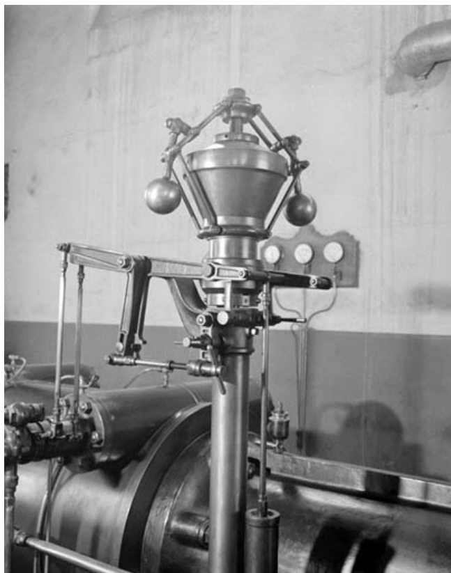
Salle des machines (10) : régulateur à boules de la machine à vapeur. 39, Dole, 65 rue de Crissey
