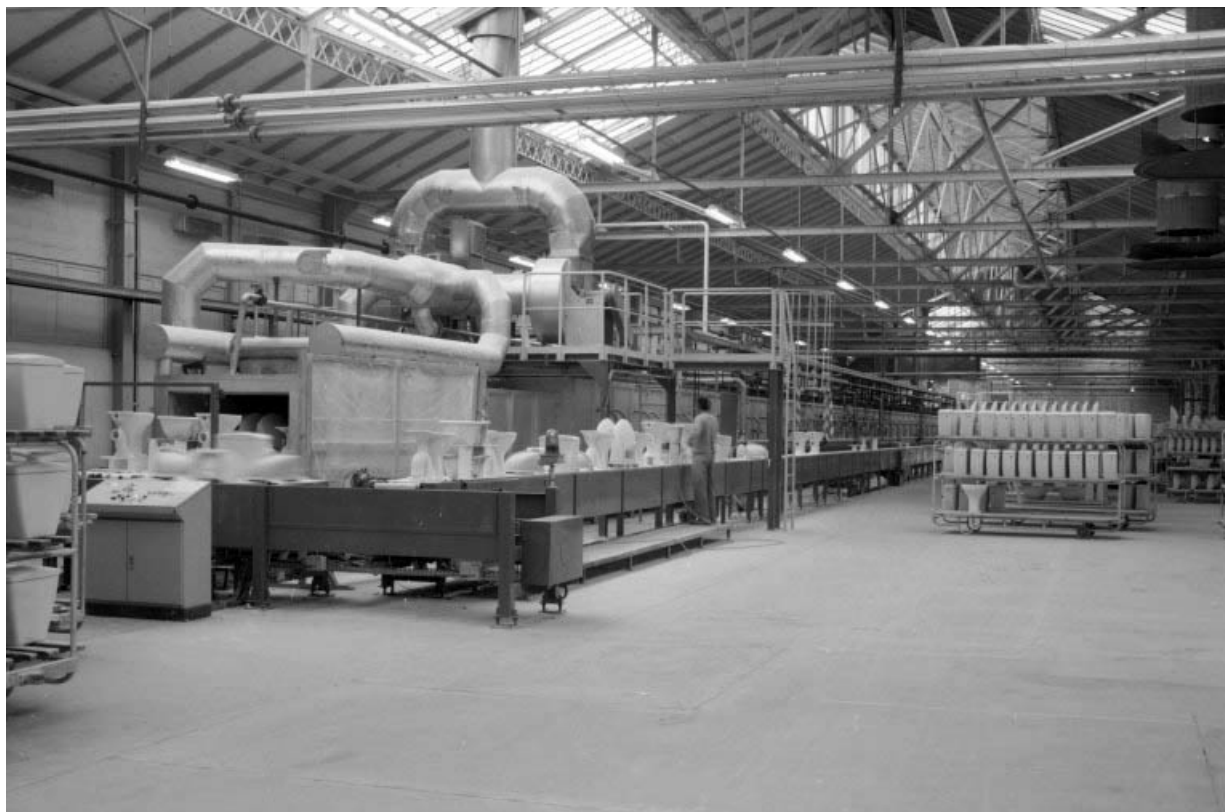
Atelier (9) : avant du four Riedhammer.
