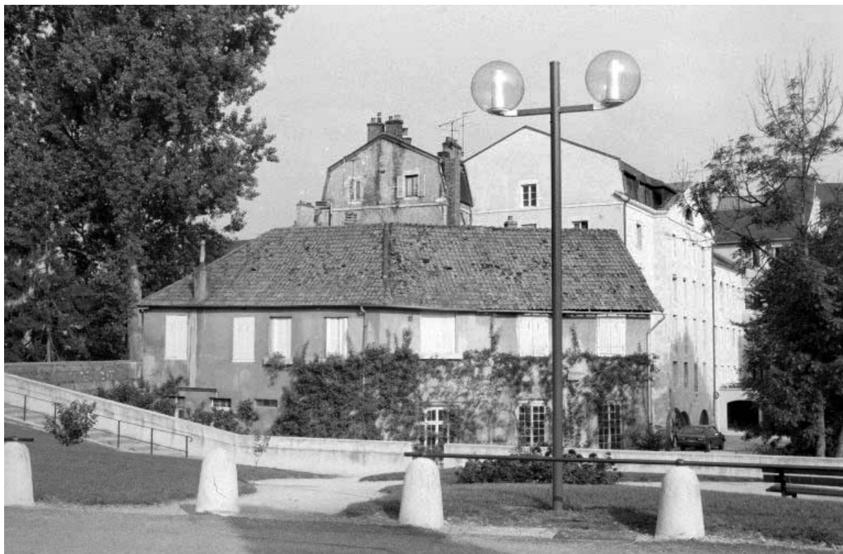
Atelier de réparation et bureau, depuis l'est.
