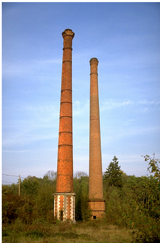
Cheminées d'usine, depuis le sud-ouest.
