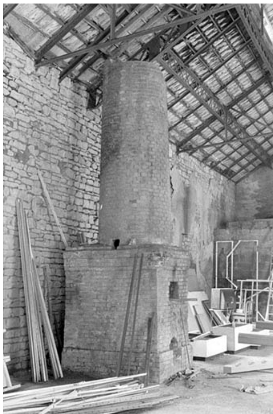
Atelier de réparation, intérieur : base de cheminée.
