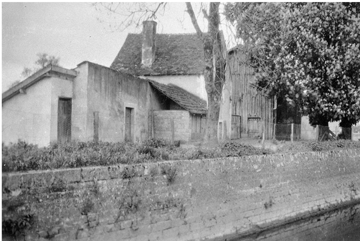
Moulin. Façade côté canal du Rhône au Rhin (habitation) depuis l'ouest.
