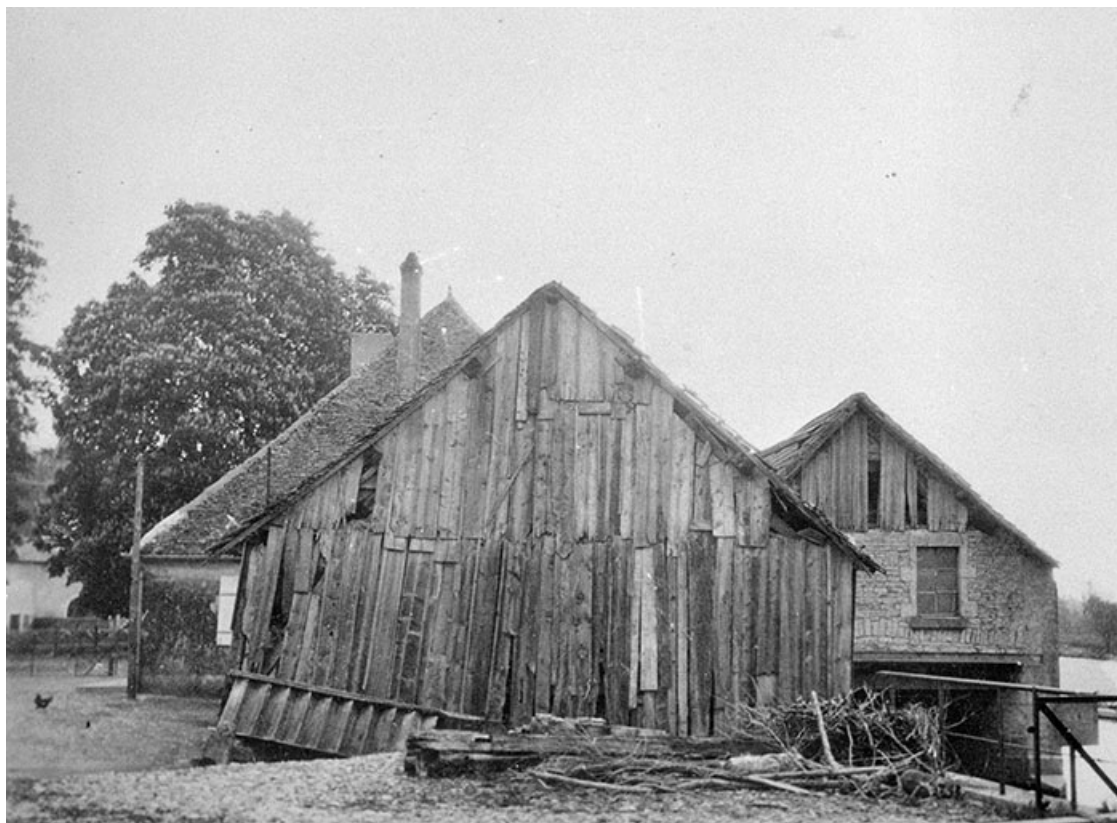
Moulin. Façade côté Usine.
