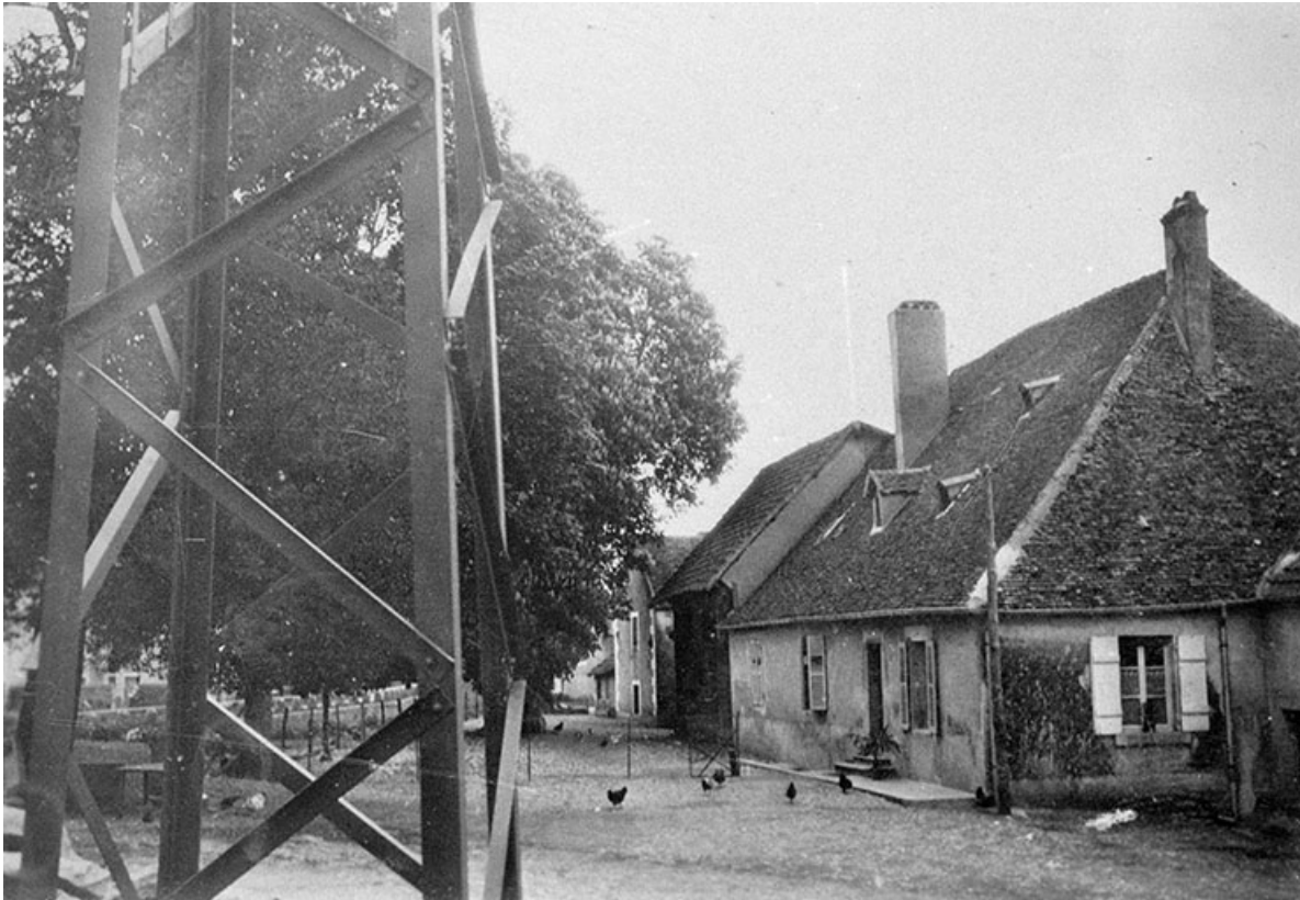
Moulin. Façade côté canal du Rhône au Rhin depuis le nord.
