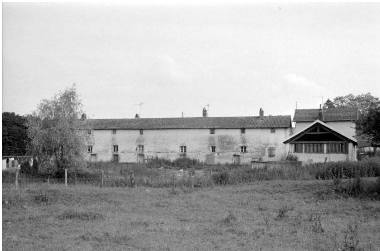
Façade postérieure des logements d'ouvriers (C) et (D).
