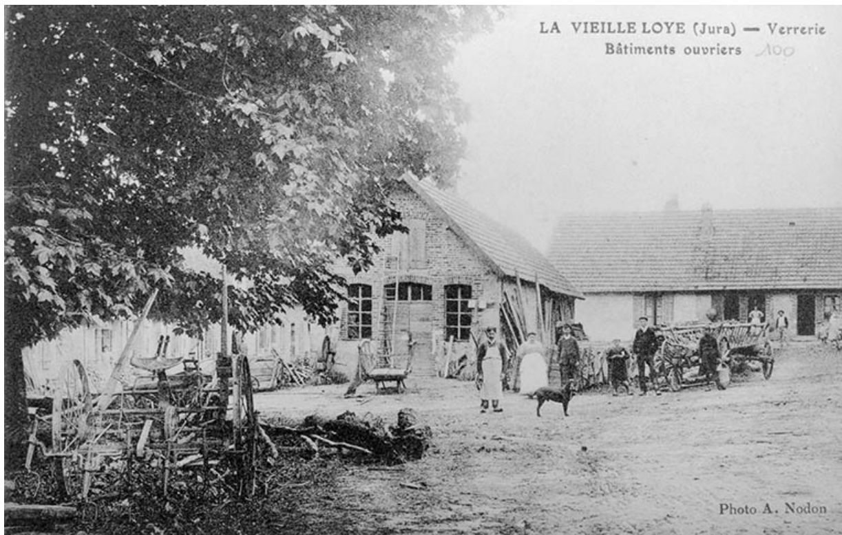
La Vieille-Loye (Jura) - Verrerie. Bâtiments ouvriers.
