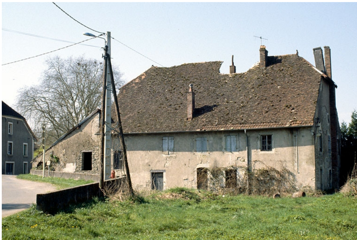
Façade antérieure du logement patronal (I). 39, Rans
