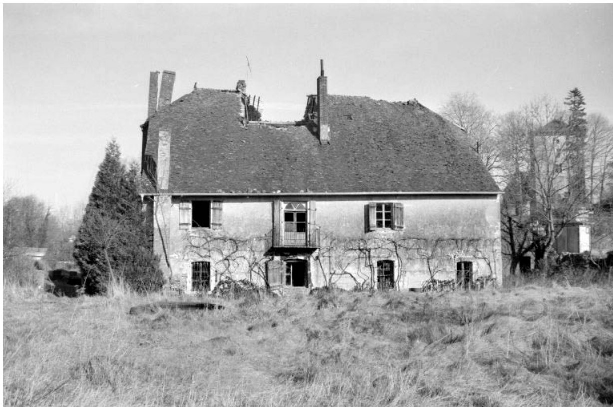
Façade postérieure du logement patronal.
