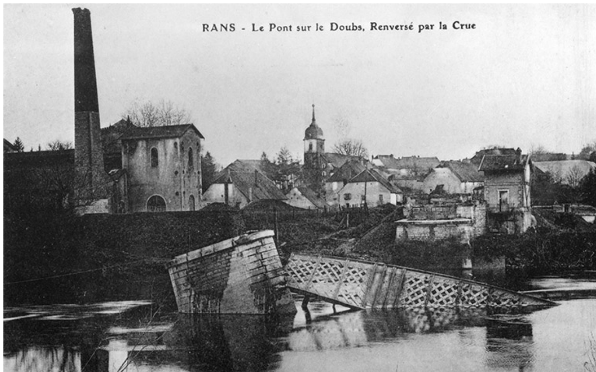
Rans - Le Pont sur le Doubs, Renversé par la Crue.
