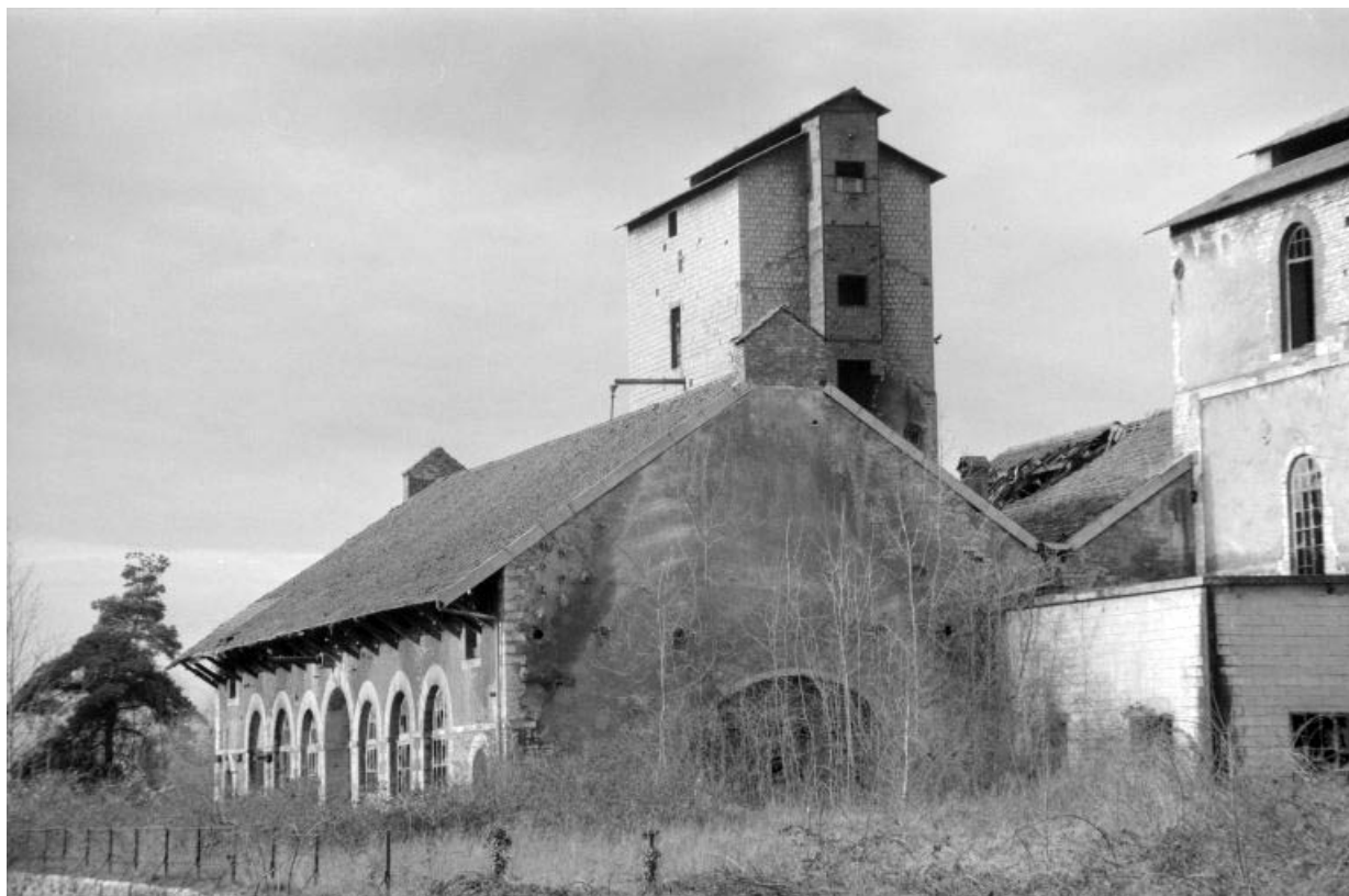
Atelier de fabrication : halle de coulée (e3) vue de l'est. 39, Rans
