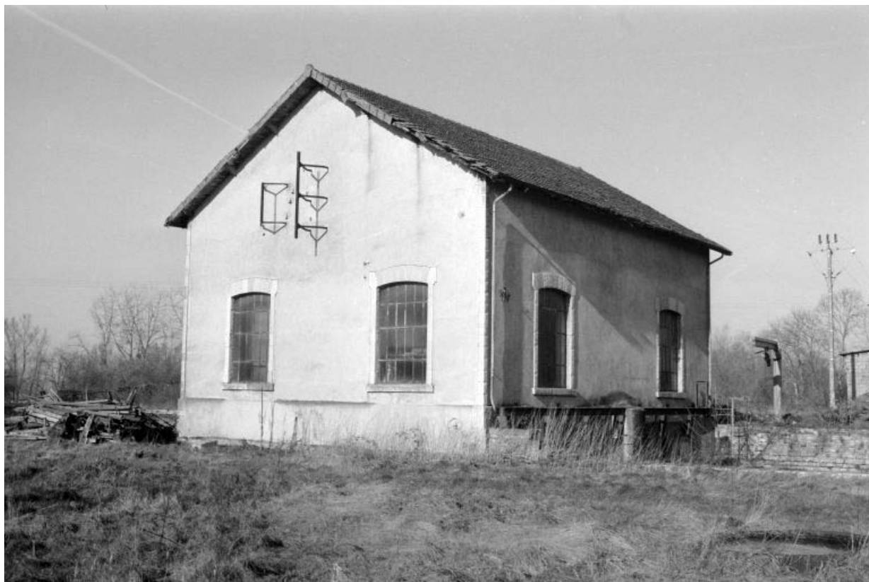
Façades postérieure et latérale gauche de la centrale hydroélectrique (G). 39, Rans
