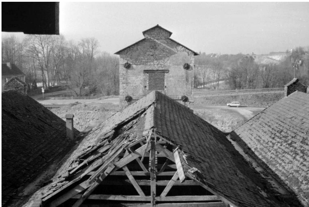
Toiture de la halle centrale de l'atelier de fabrication et monte-charge (D). 39, Rans
