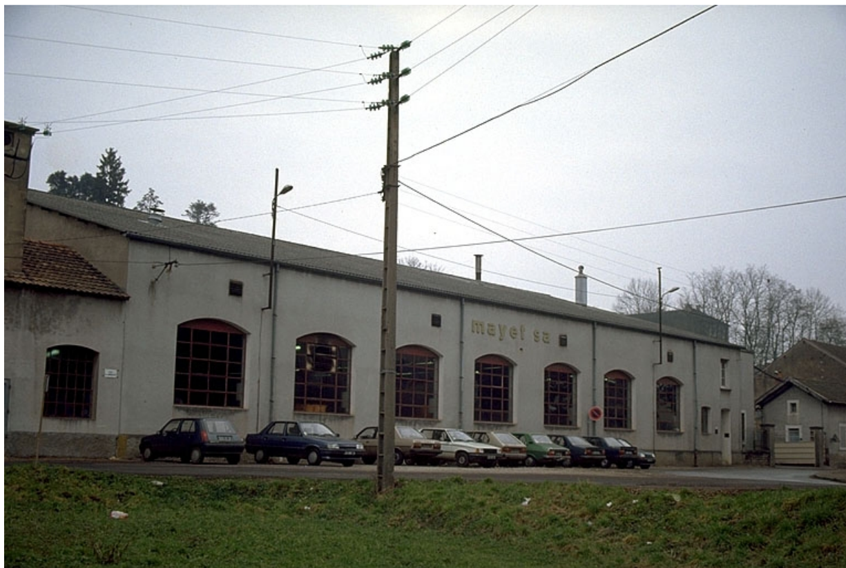
Façade antérieure de l'atelier de fabrication.
