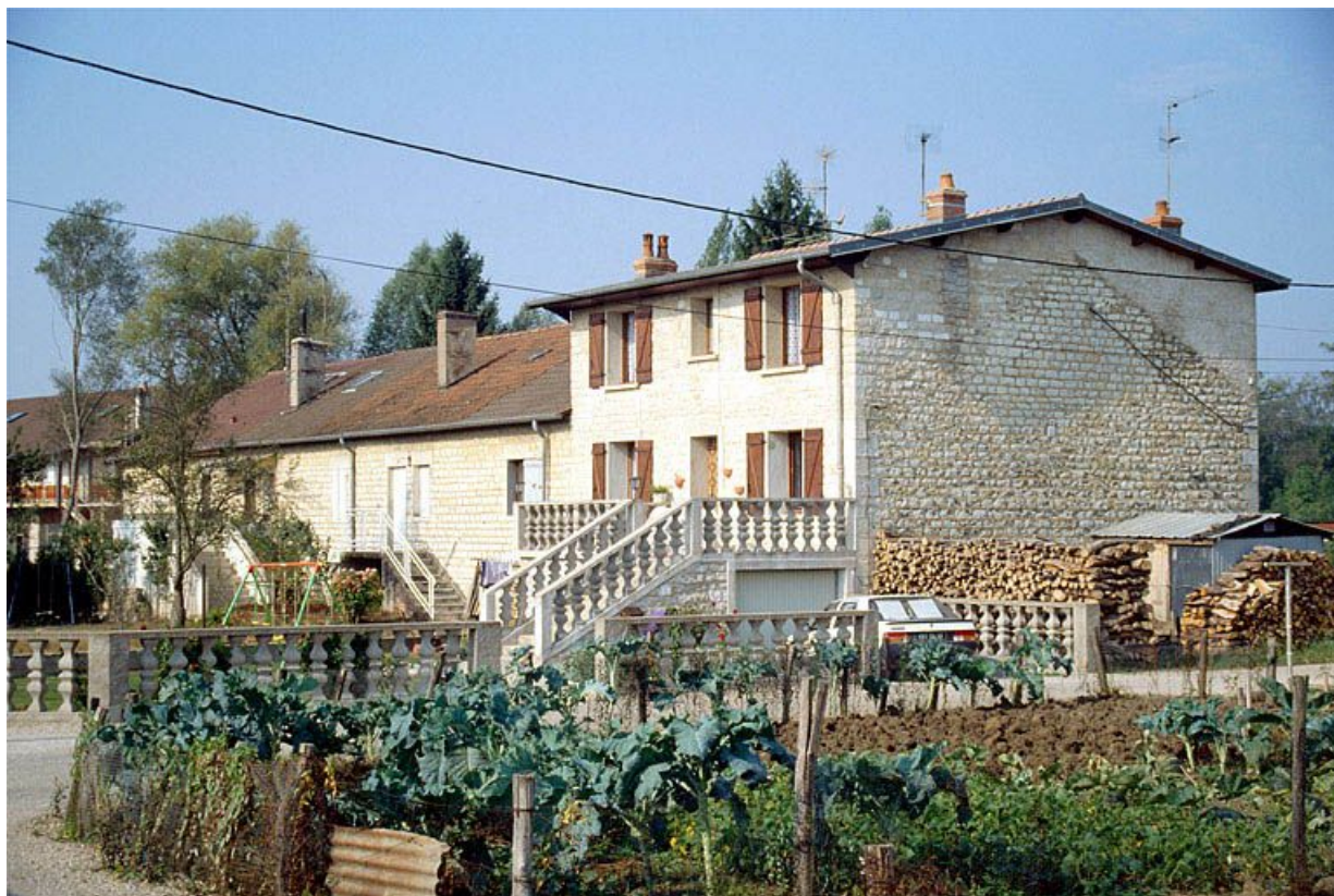
Maison de la cité ouvrière (12-26, rue des Anciennes forges) vue de l'est. Cadastre : 1980 AK 146, 149, 152, 208 à 210. 39, Foucherans, 1 à 7 rue des Anciennes Forges
