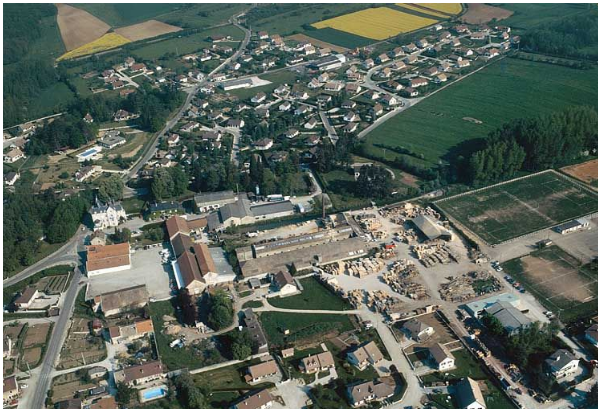
Vue aérienne de l'usine depuis le sud-est (vue rapprochée).
