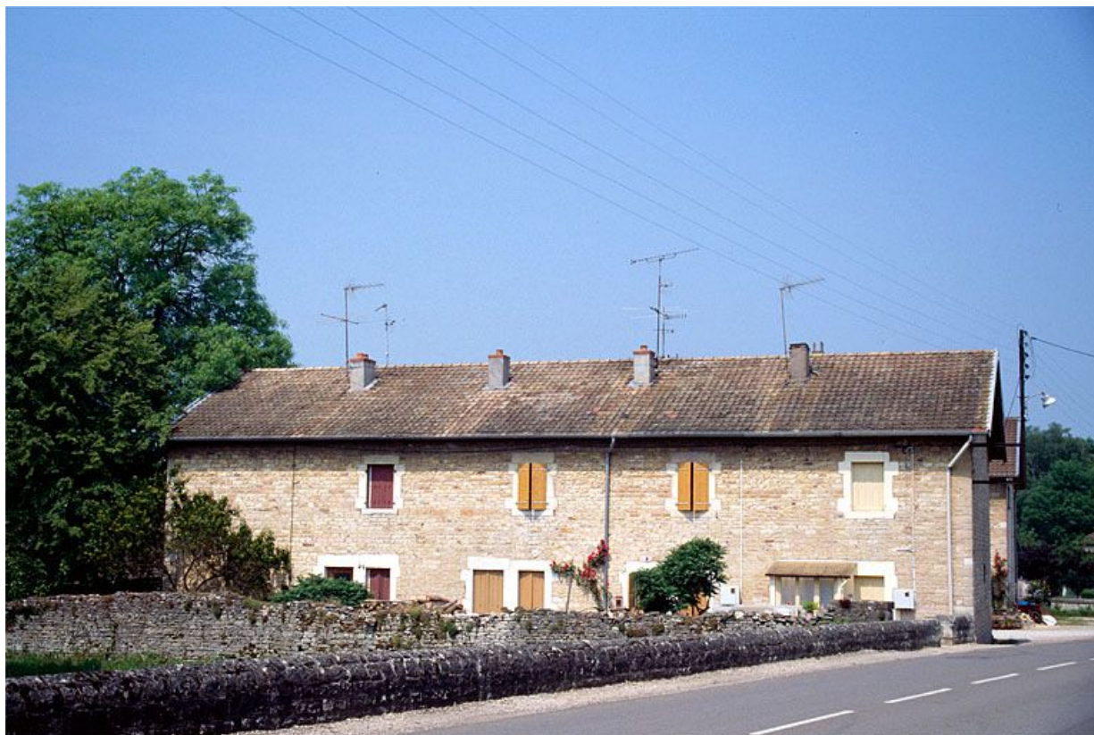
Maison de la cité ouvrière (46-58, rue des Anciennes forges) vue de l'est. Cadastre : 1980 AK 168 à 172. 39, Foucherans, 1 à 7 rue des Anciennes Forges
