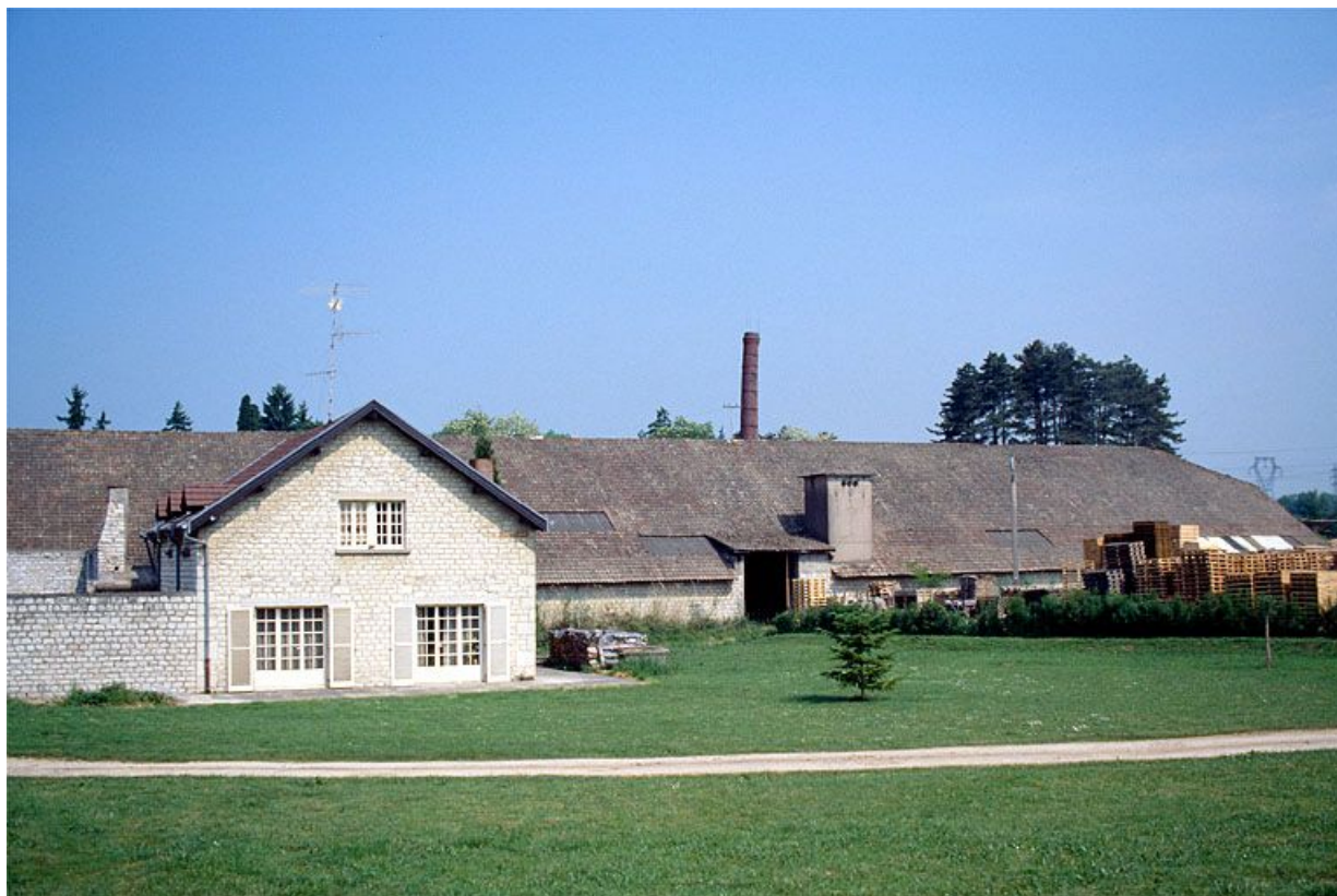
Chaudière (P) et atelier de fabrication (N) vus de l'est.
