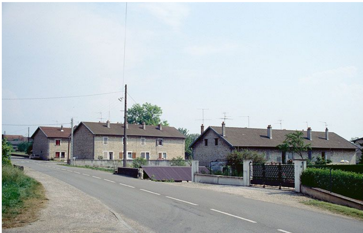
Vue d'ensemble de la cité ouvrière, depuis le nord.
