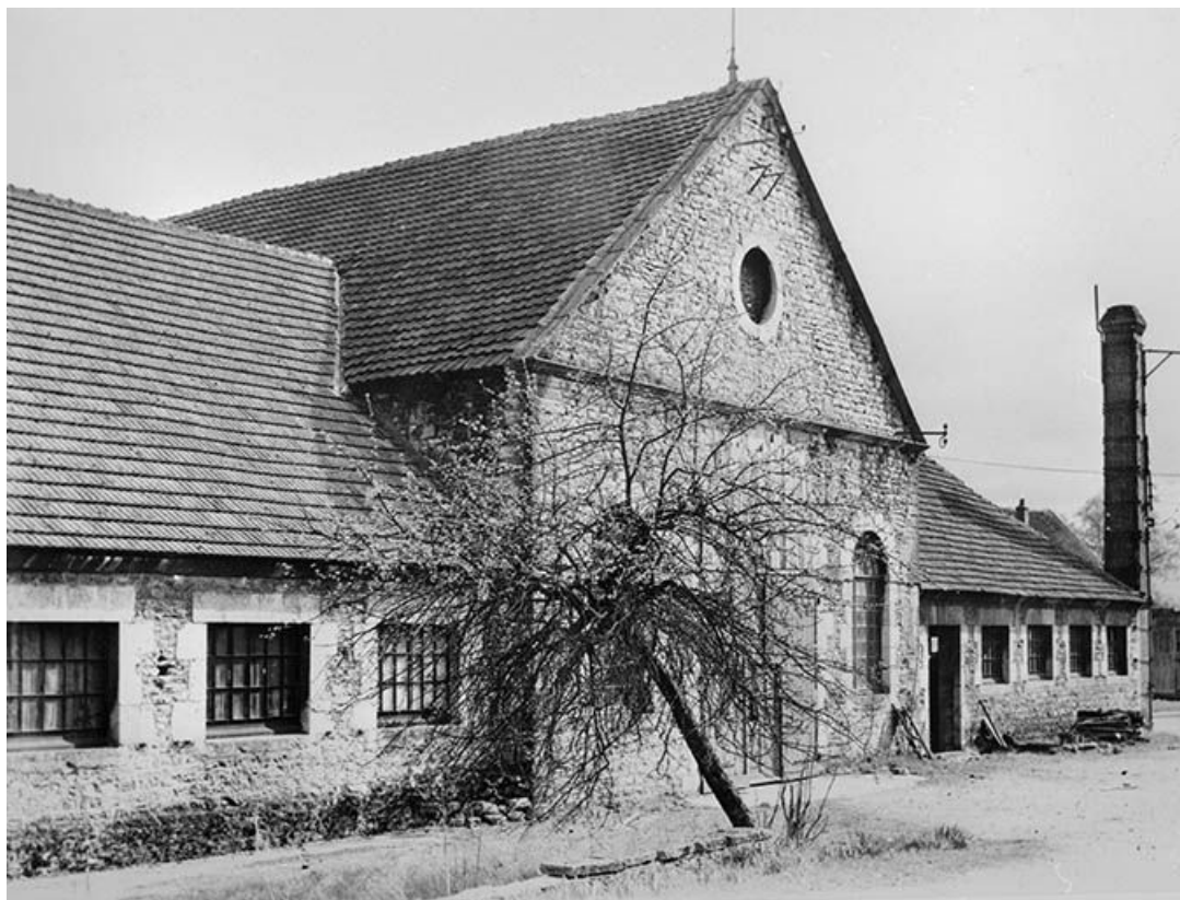
Conserverie (atelier de fonderie F) : mur pignon nord.
