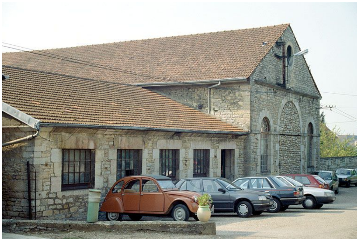
Atelier de moulage (E) et extrémité de la fonderie (F).
