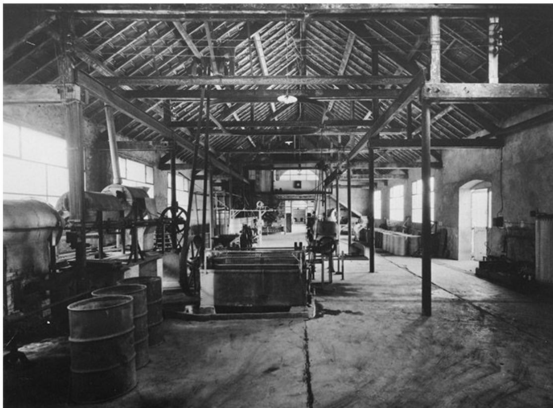
Conserverie (atelier de fonderie F2) : intérieur de l'atelier de fabrication.
