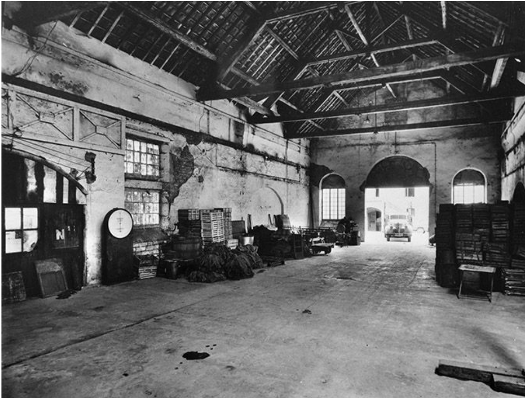
Conserverie (atelier de fonderie F1) : intérieur de l'arrivage.
