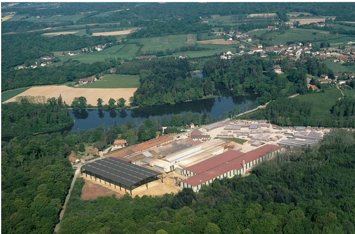
Vue aérienne depuis l'est.
