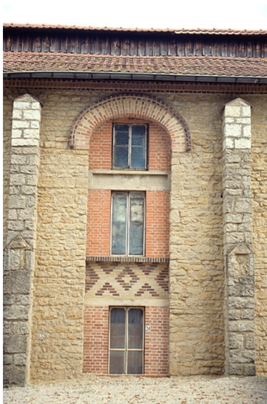
Atelier (A) : détail d'une travée étroite.
