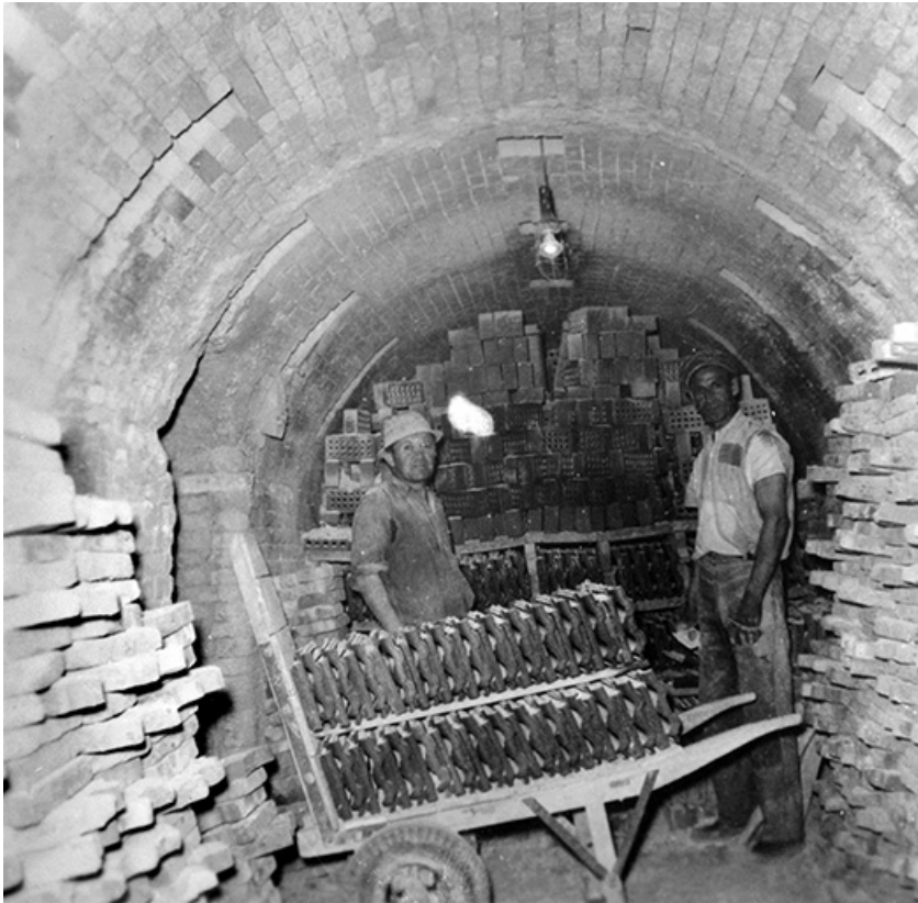
Déchargement du four Hoffmann.
