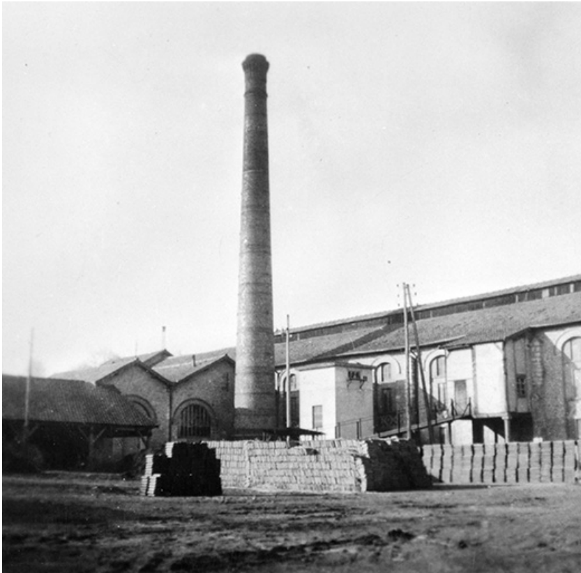
Ateliers et cheminée vus du nord.
