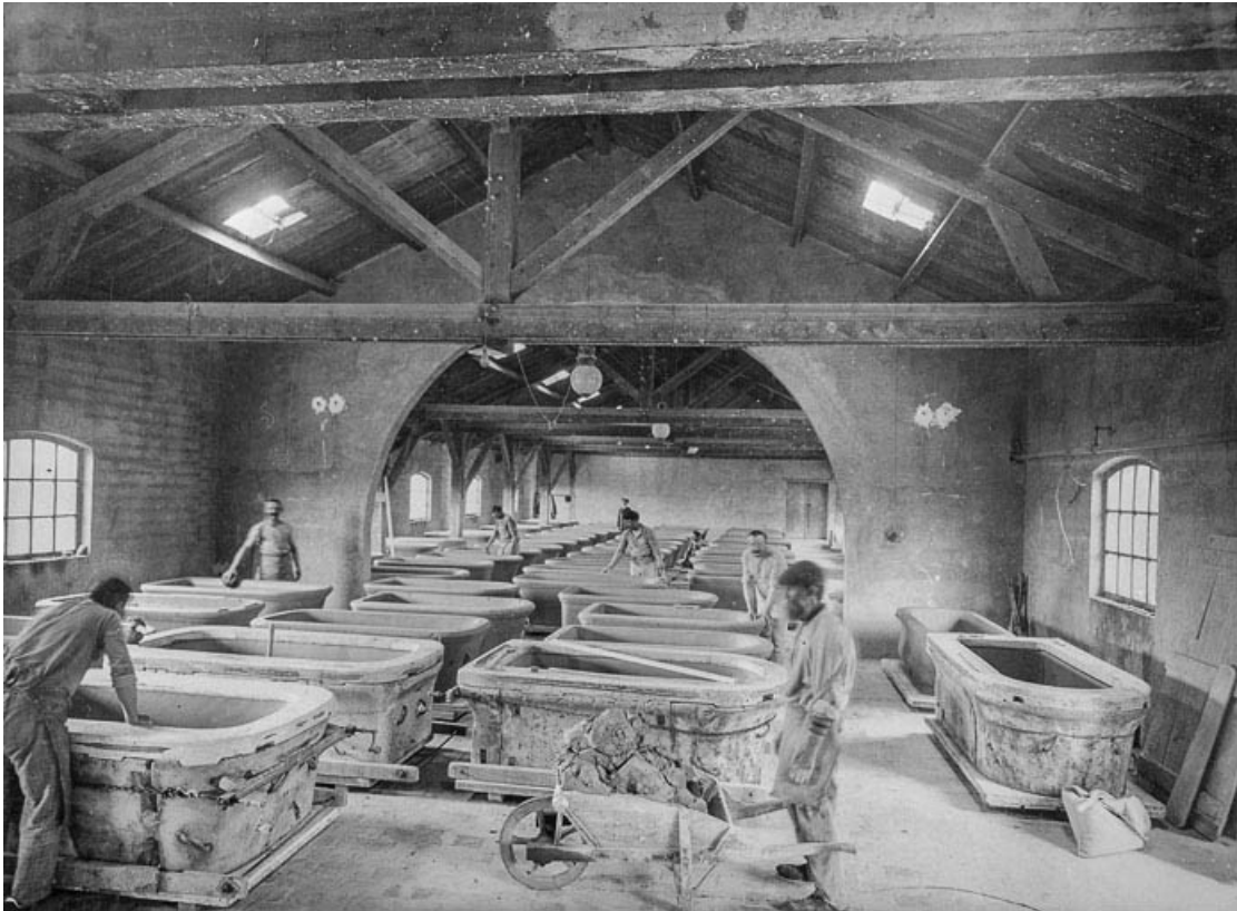
Le moulage des baignoires (bâtiment 42).
