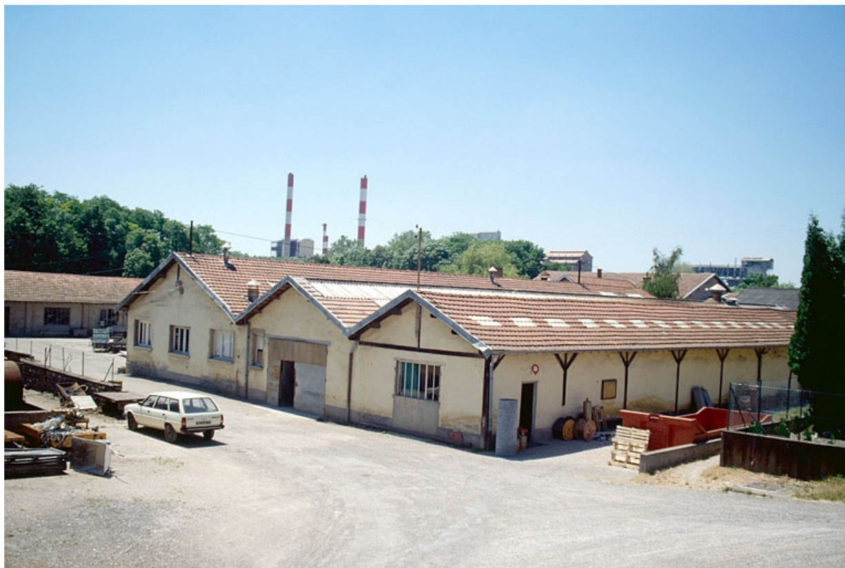
Atelier de réparation (31), vu de trois quarts droit.
