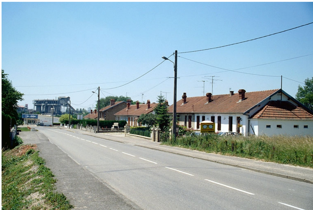
Cité ouvrière, partie sud : maisons à l'ouest de la route.
