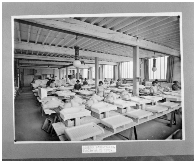
L'atelier d'émaillage, salle n° 1 (bâtiment 46).
