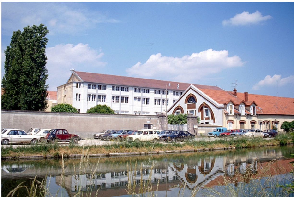
Bureaux (20) et atelier de coulage des moules (42), depuis le sud.
