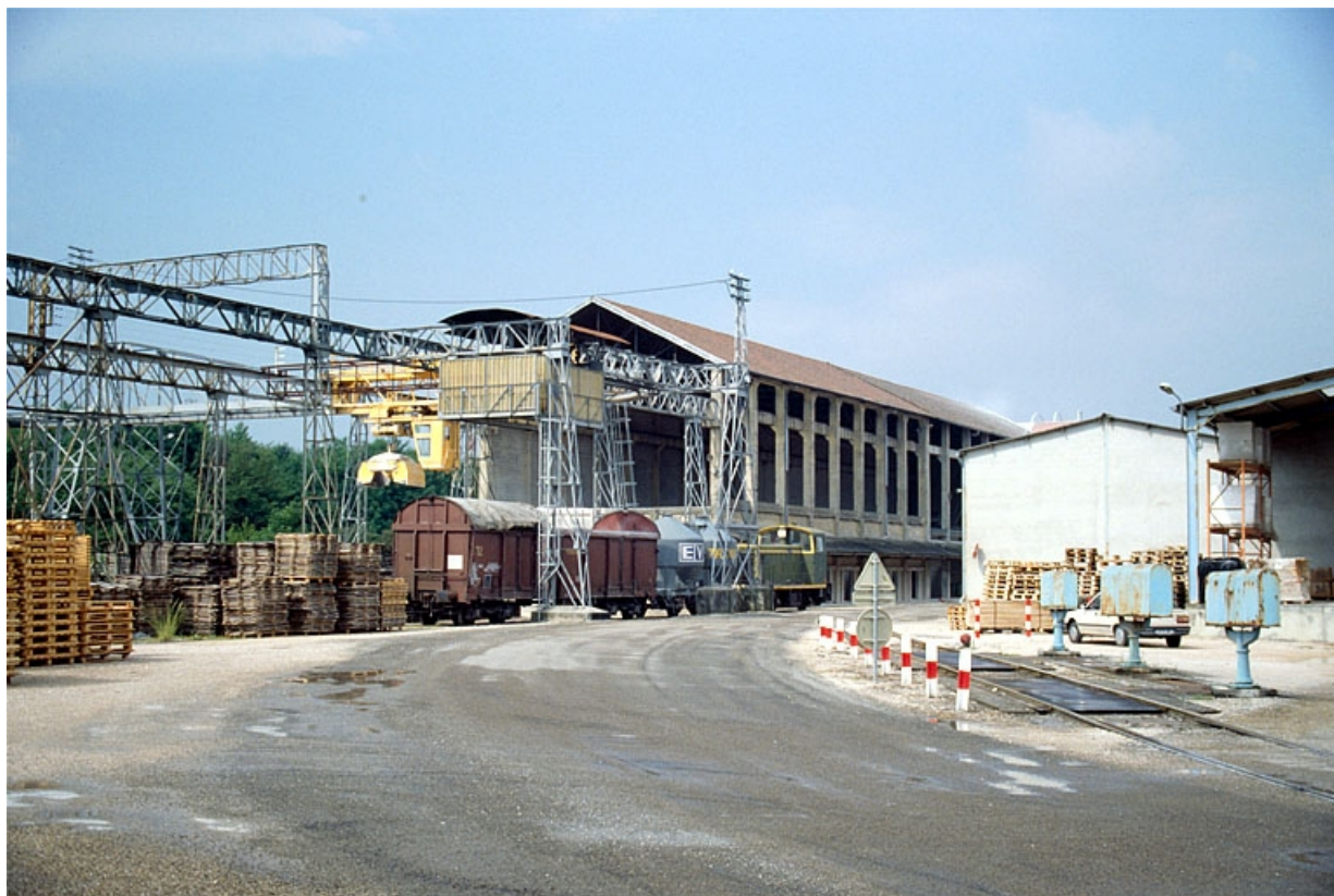
Pont-bascule (40), pont roulant (17) et hangar à terre (18).
