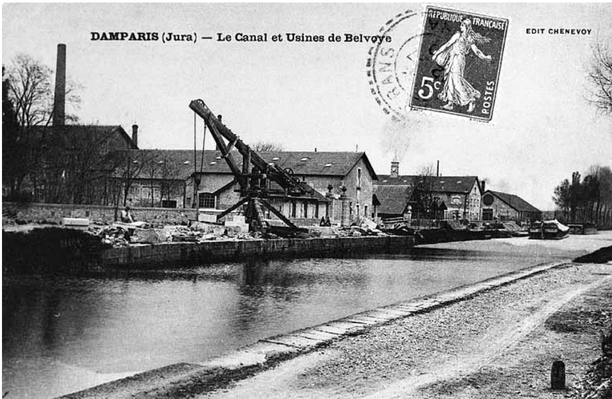
Damparis (Jura). Le Canal et Usines de Belvoye.
