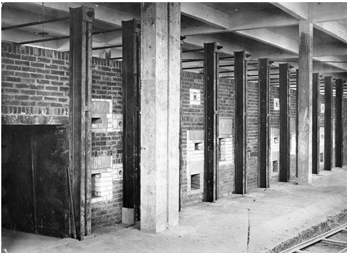
Four Dressler en construction : vue latérale.
