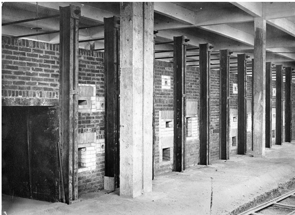
Four Dressler en construction : vue latérale.
