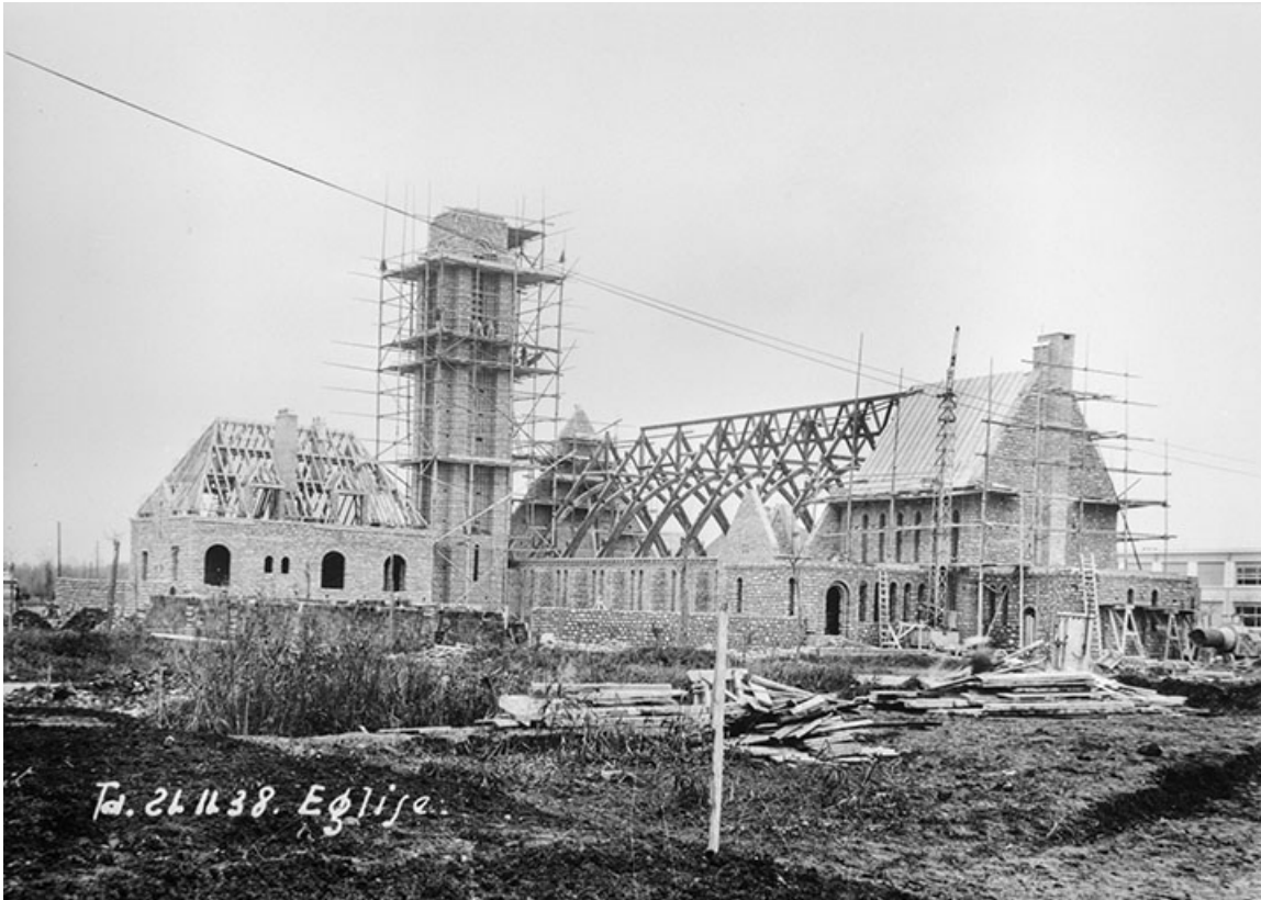
Travaux de construction de l'église, vue du sud-est.
