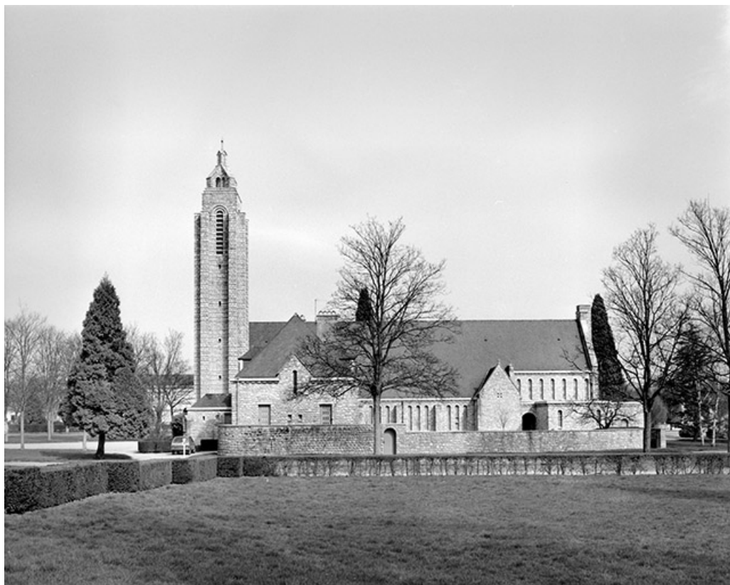
Façade latérale droite, vue depuis le jardin de l'hôpital.
