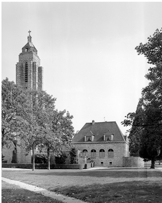
Façade ouest du presbytère et clocher.
