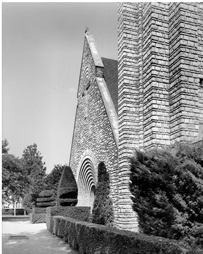
Façade ouest, vue de trois quarts.
