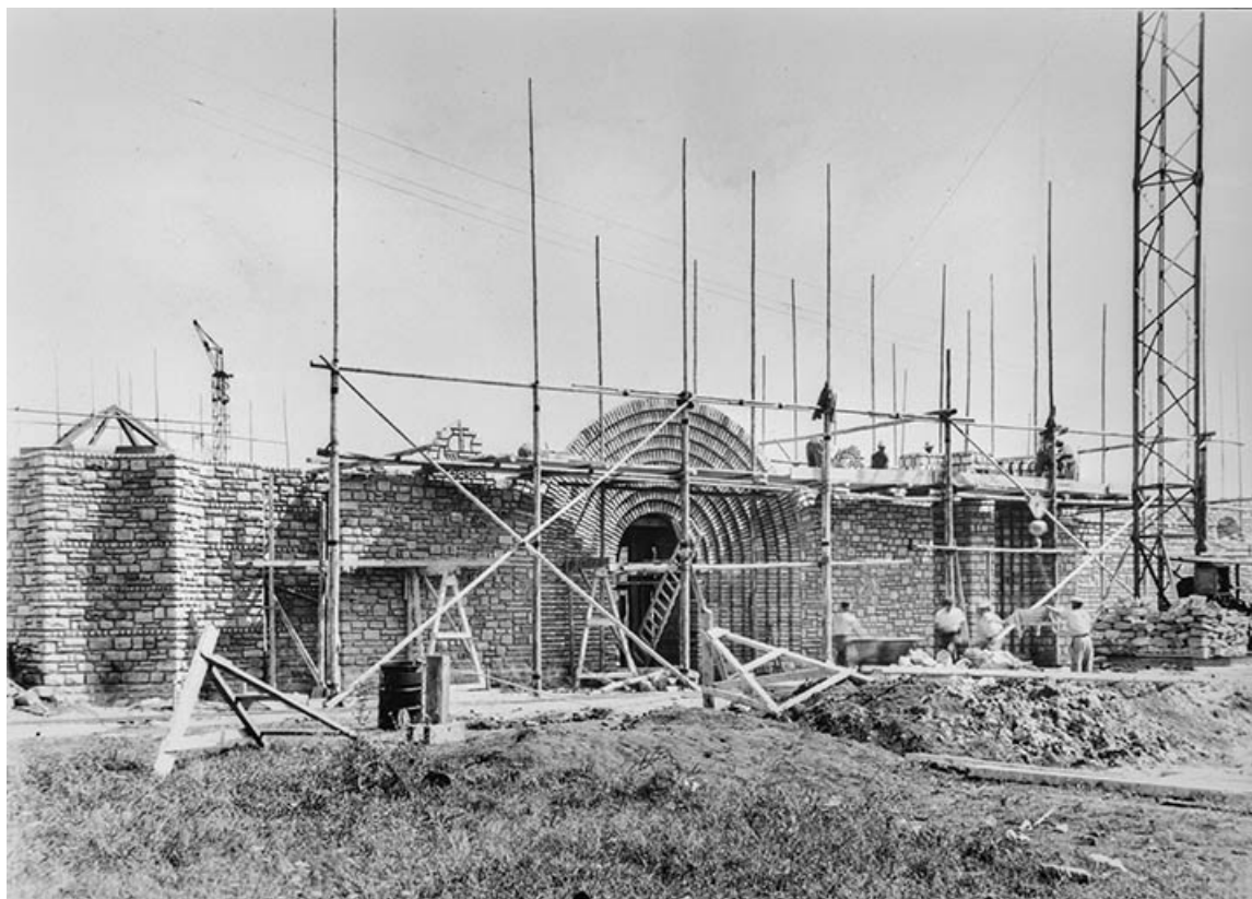
Travaux de construction de l'église, façade ouest.
