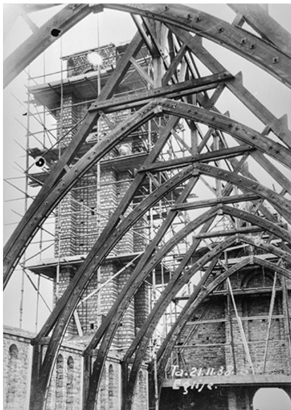
Travaux de construction de l'église, charpente de la nef. 39, Tavaux, lieudit : Tavaux Cité
