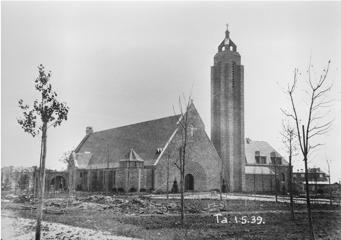
Travaux de construction de l'église, vue du nord-ouest.
