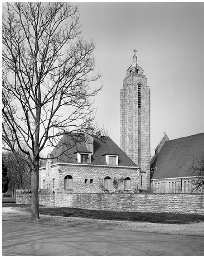
Face postérieure du presbytère et tour-clocher.
