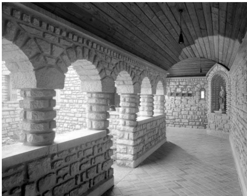
La galerie reliant l'église au presbytère.
