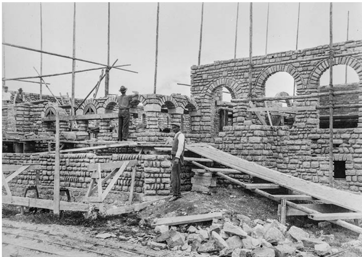
Travaux de construction de la galerie reliant l'église au presbytère.
