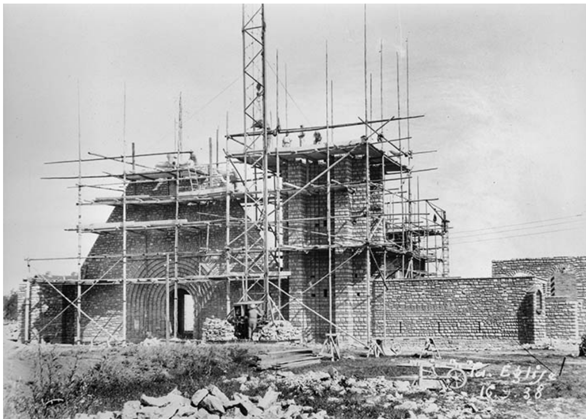
Travaux de construction de l'église, façade ouest.
