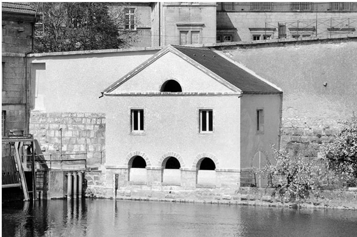
Logement du fontainier en 1990.
