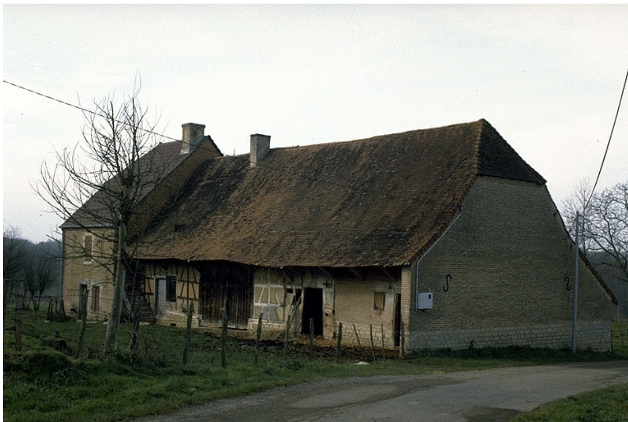
Etable et logement patronal, depuis l'est.
