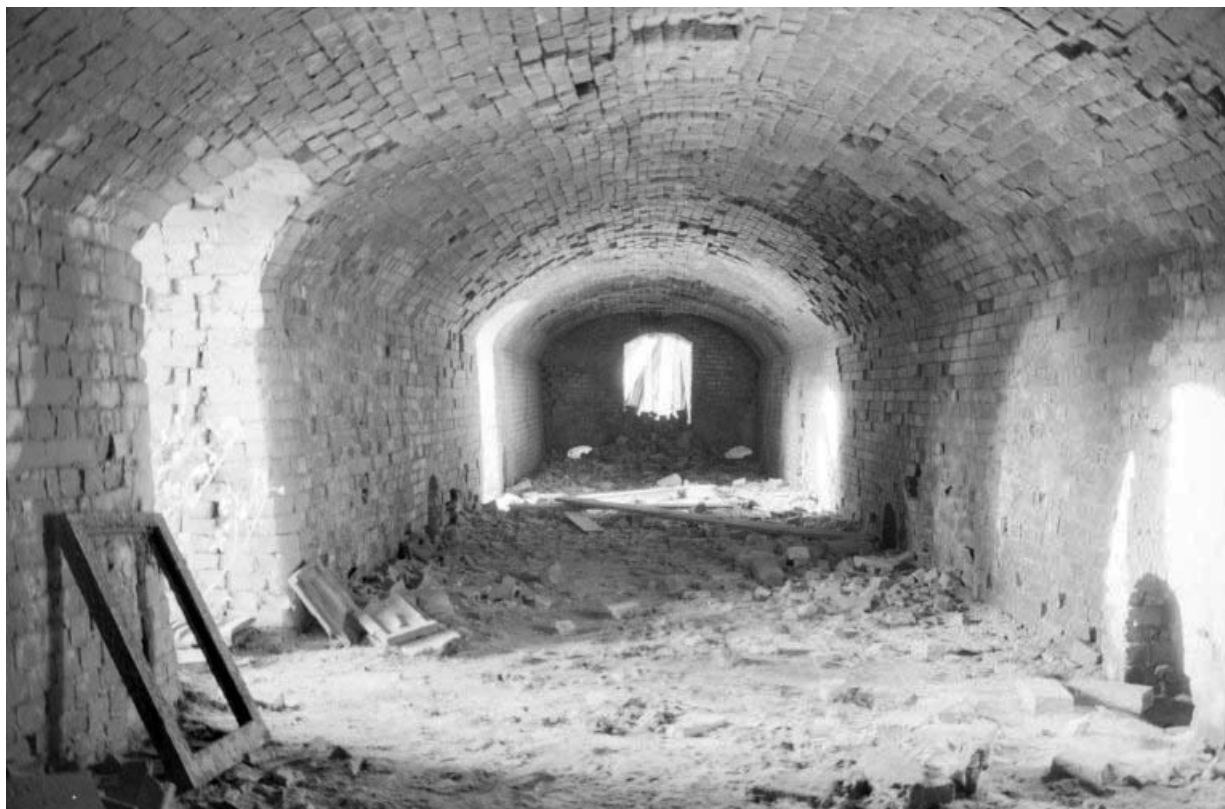
Atelier de fabrication : intérieur du four.
