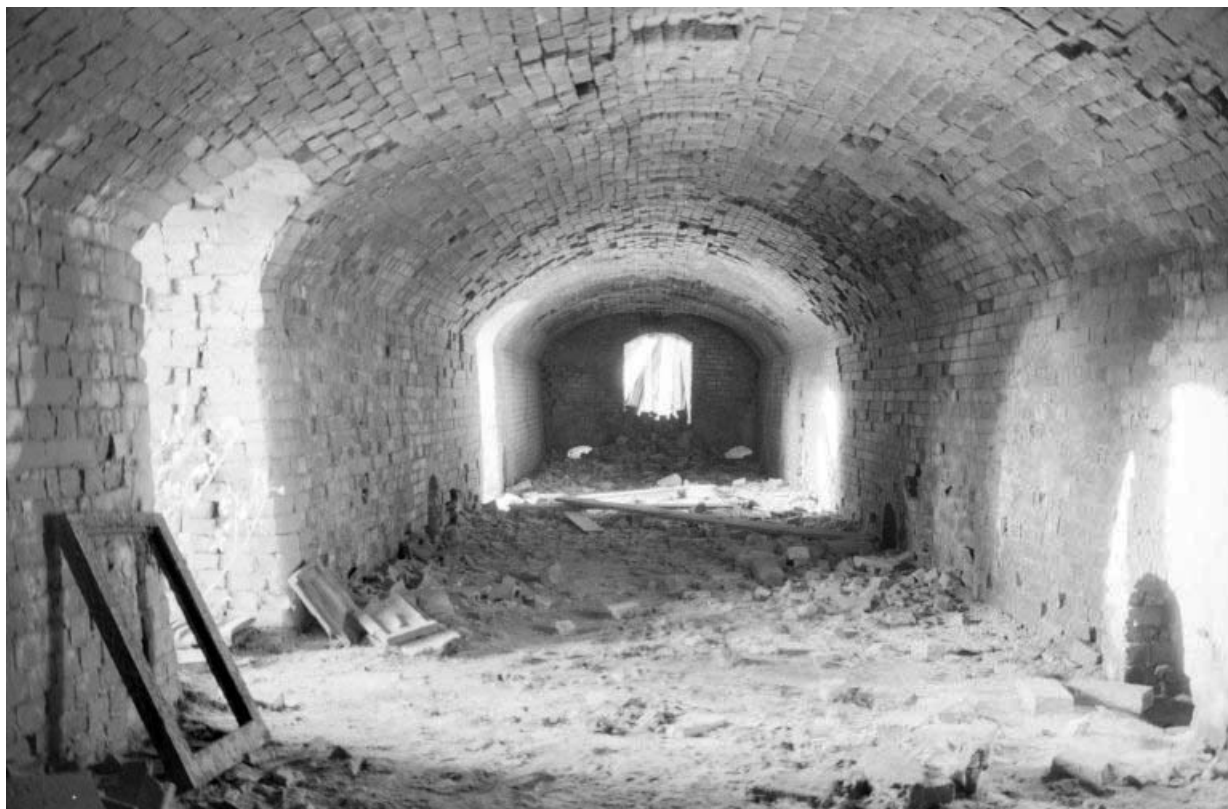
Atelier de fabrication : intérieur du four.
