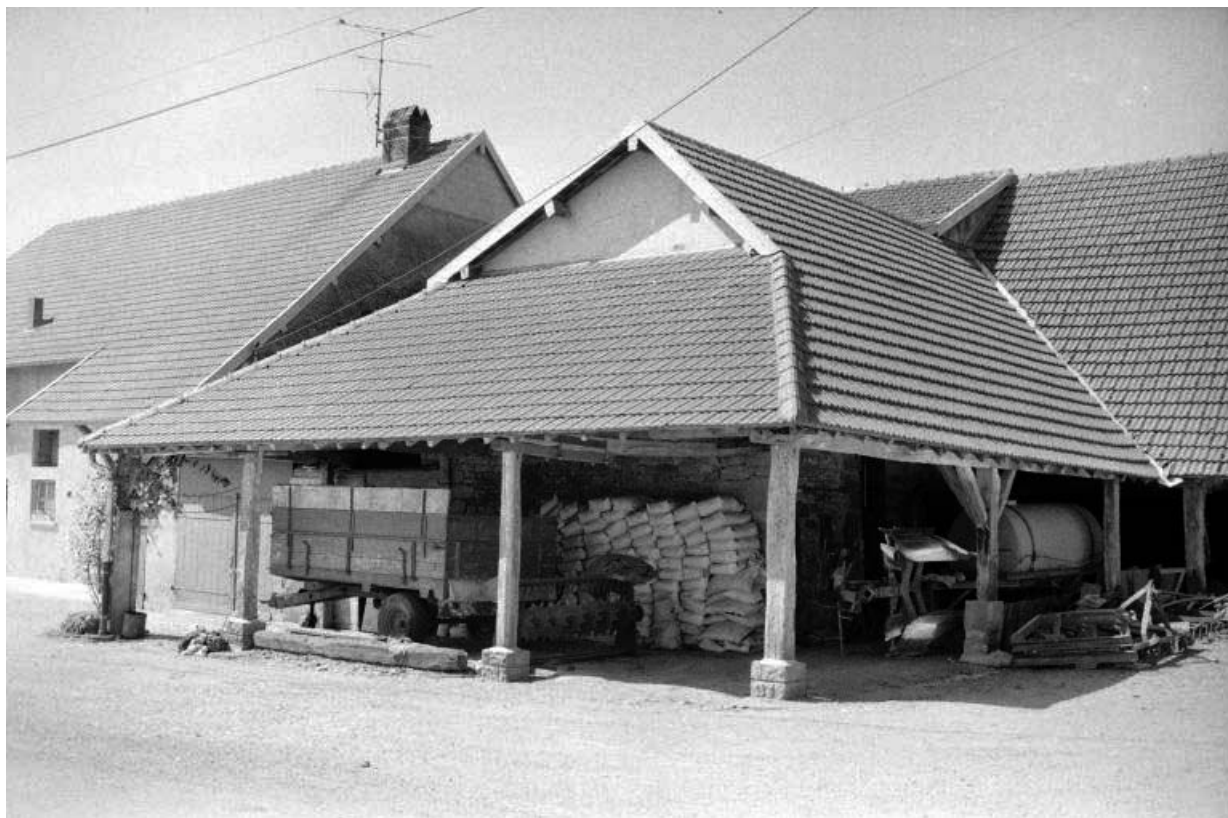
Corps de bâtiment abritant le 1er four.
