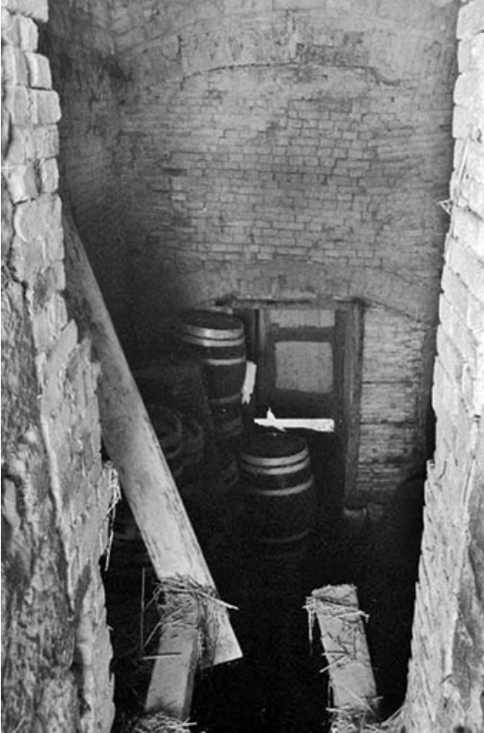
Intérieur du 1er four, depuis la porte d'enfournement. La voûte du foyer a été supprimée. 39, Vitreux
