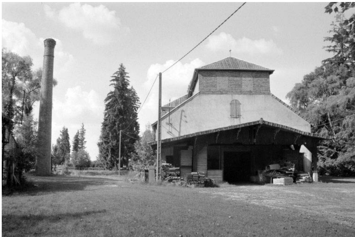
Cheminée d'usine (F), hangar (E) et atelier de fabrication (D).
