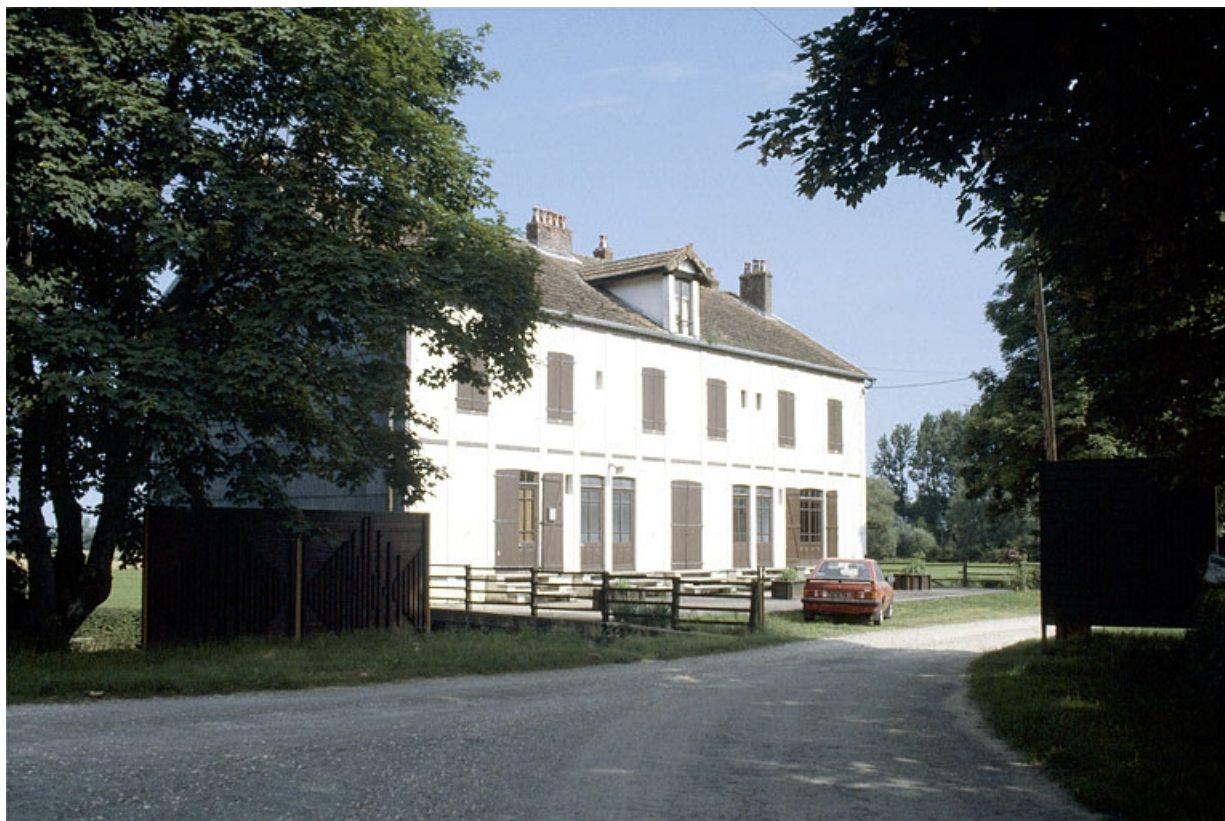
Logement d'ouvriers (O), depuis l'entrée de l'usine.
